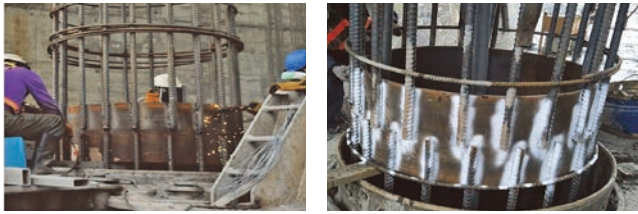
圖 33 基樁鋼筋搭接施工相片
