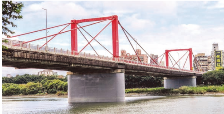
圖 44 光復大橋完工相片
