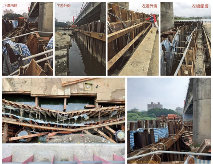
圖 25 墩柱 P10 圍堰變形相片
