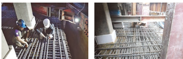
圖 35 墩柱 P10 第一層基礎上層鋼筋施工相片
