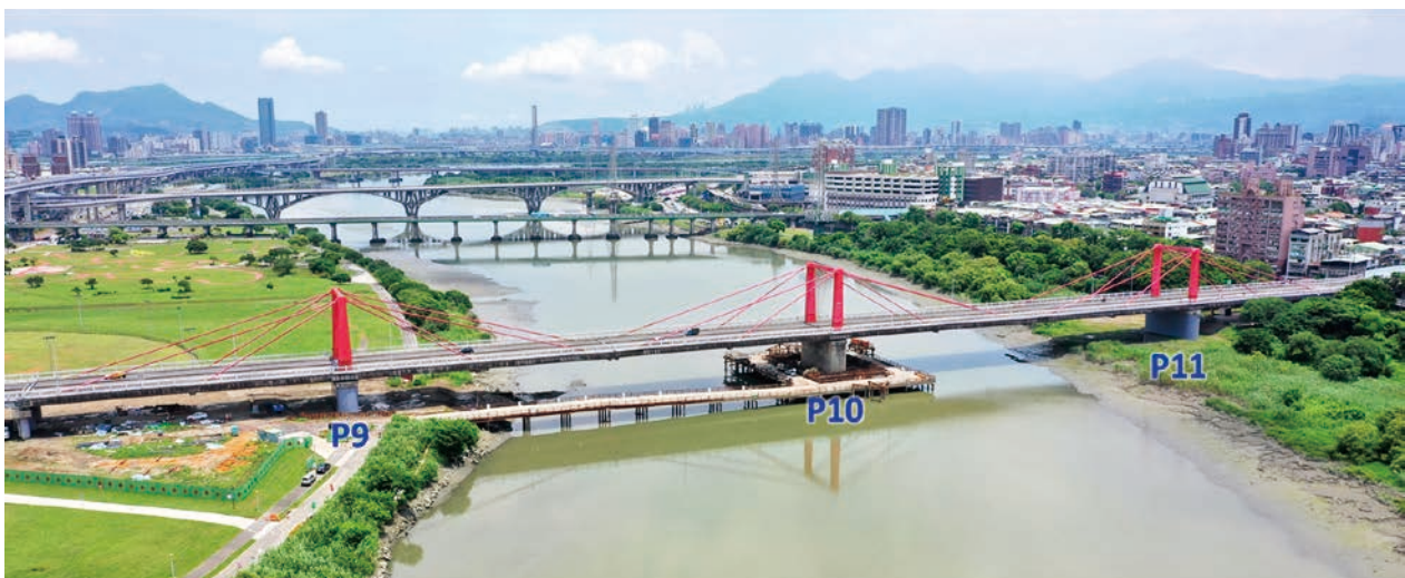
圖 15 墩柱基樁補強現場
