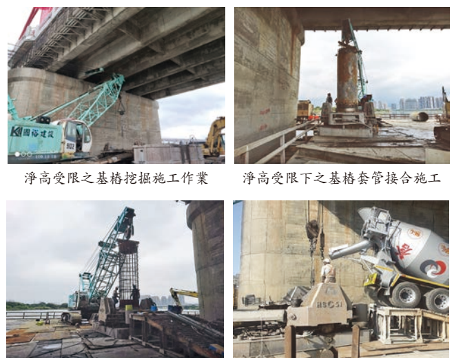
淨高受限之鋼籠搭接施工
