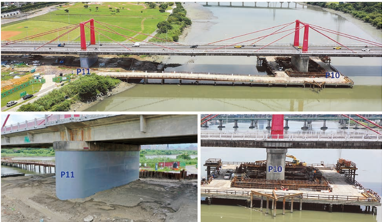
圖 17 墩柱 P10 之施工便橋及施工構台配置
