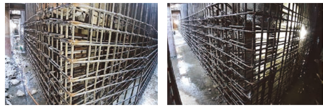
圖 39 墩柱 P10 第二層基礎鋼筋施工相片
