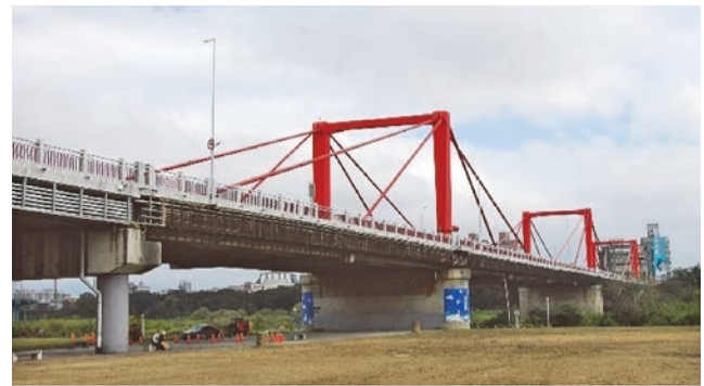
圖 2 光復大橋現況相片
