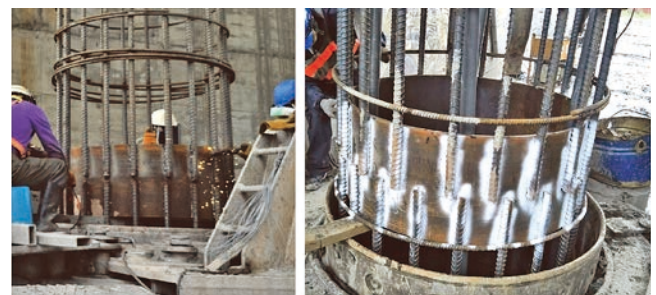
圖 18 基樁鋼筋搭接施工相片
