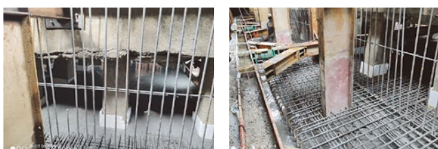
圖 37 墩柱 P10 第一層基礎混凝土澆注施工相片
