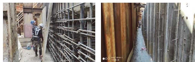
圖 40 墩柱 P10 第二層基礎組模相片
