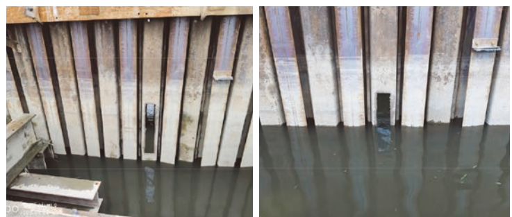
圖 29 雙層鋼板樁圍堰開孔現況相片
