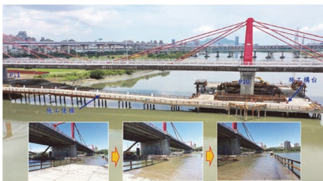
圖 31 墩柱 P10 之施工便橋及施工構台配置
