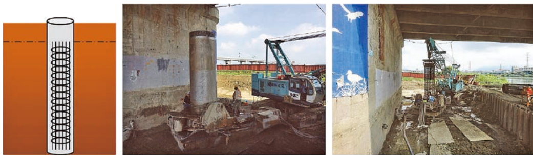
圖 19 墩柱 P9 及 P11 基樁施工示意圖及相片
