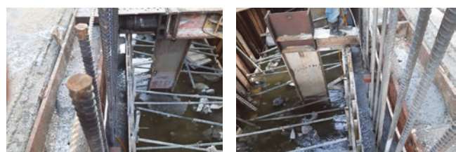
圖 42 墩柱 P10 第二層基礎基礎養護相片
