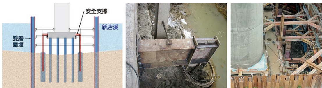
圖 21 墩柱安全支撐示意圖及施工相片
