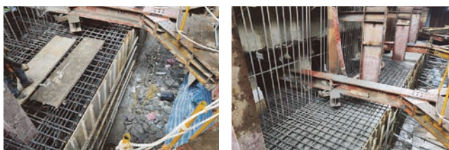
圖 36 墩柱 P10 第一層基礎組模施工相片
