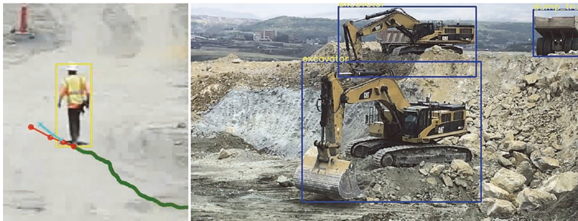
圖 12 運用深度學習偵測及預測工人、機具移動方向以分析生產力及安全 [29] 。
