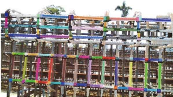
(a) 鋼筋組立結點與間距的實例分割結果
