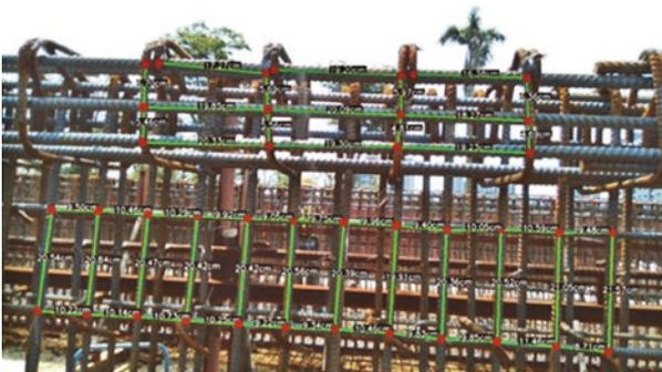
(b) 鋼筋間距真實尺度計算結果
