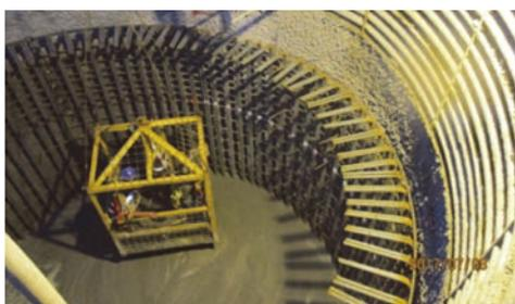
(b) 查驗人員進入吊箱以目視執行鋼筋查驗作業
