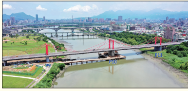
光復大橋墩柱基樁補強現場
