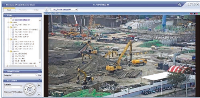
圖 19 CCTV 操作畫面
