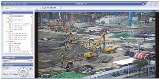
圖 19 CCTV 操作畫面
