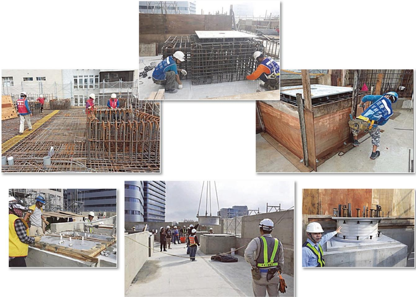
圖 23 隔震基座現場施工實況圖
