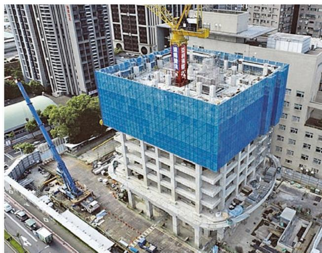
圖 17 自爬升式施工架爬升完成實況
