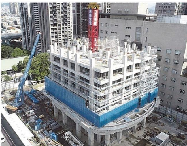
圖 16 自爬升式施工架現場組裝實況
