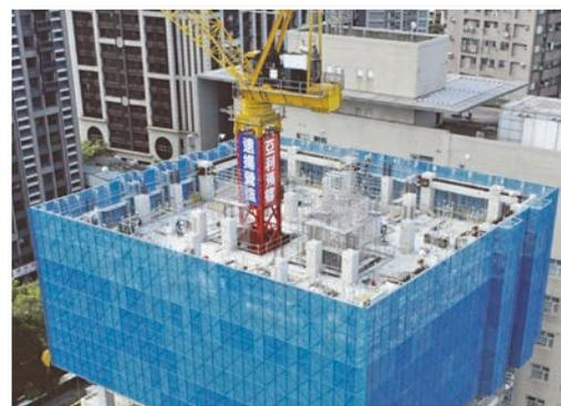
圖 15 自爬升式施工架現場使用實況
