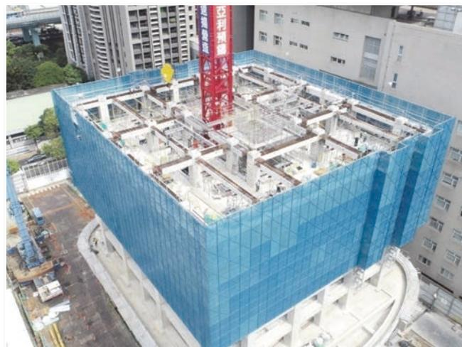
圖 13 新式蓮根梁預鑄工法現場施工實況圖
