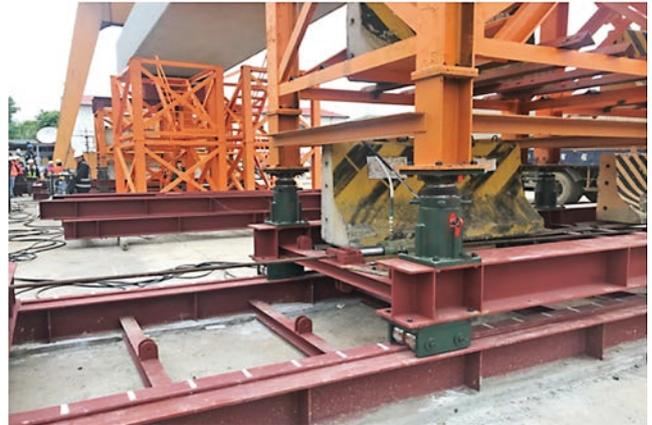
圖 7 支撐架底部橫向移動機構
