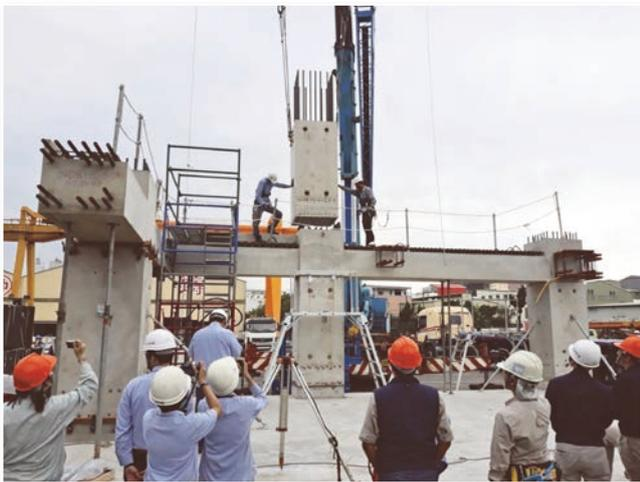
圖 10 預鑄廠內實體模型吊裝研討實況
