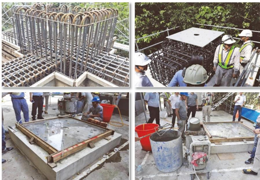
圖 22 隔震基座鋼筋及相關配置實體模型施作實況 (依 BIM 檢討結果製作)
