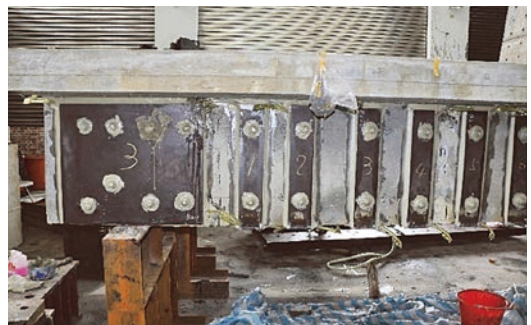
(c) 鋼板邊緣填充 EPOXY 樹脂
