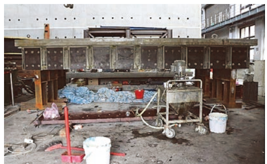
(d) 鋼板和混凝土之間填滿 EPOXY 樹脂
