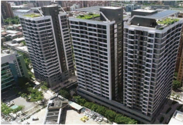
臺北市南港區東明公共住宅統包工程 提供物管駐點服務 提升入住品質
