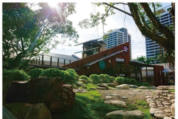
臺北市南港瓶蓋工廠歷史建築及建物整修工程 古蹟修復 創造藝術交流
