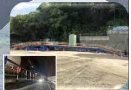
隧道棧橋工法
