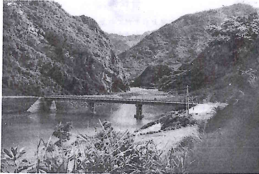
施工前之壩址(大橋已在完工後拆除)
