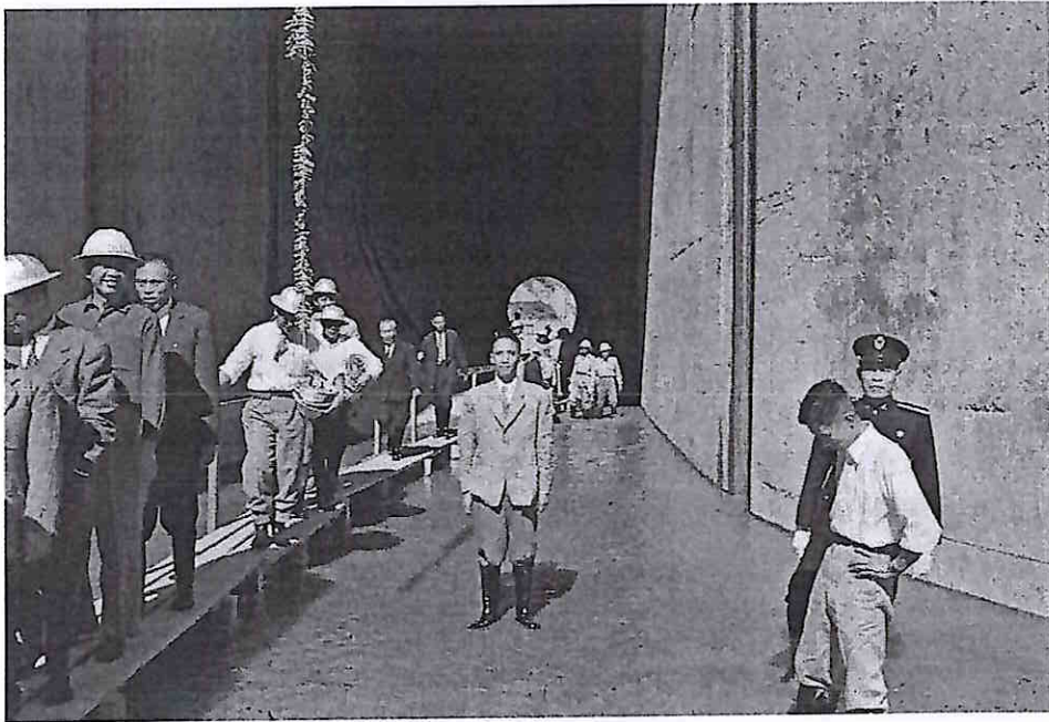
導水隧道封閉蓄水
