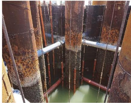
圖 11(b) 逐階抽水及臨時抗浮支撐施工
