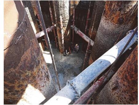
圖 11(c) 抽水及臨時抗浮轉換完成
