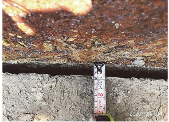
圖 14 鋼箱側模變位情形
