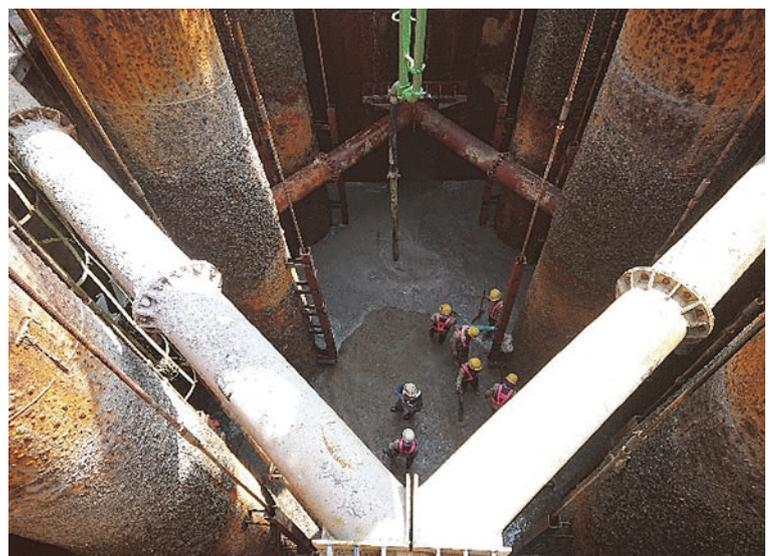
圖 12(b) 第二次封底澆置
