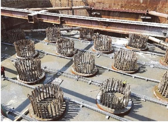
圖 13 鋼箱圍堰工作面樁頭處理完成情形
