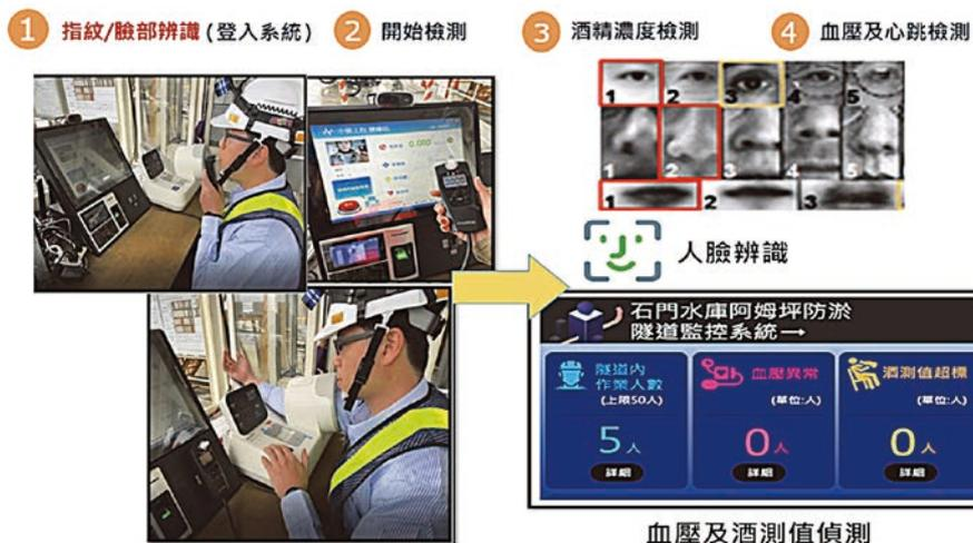
圖 6 隧道工作人員生理監測程序
