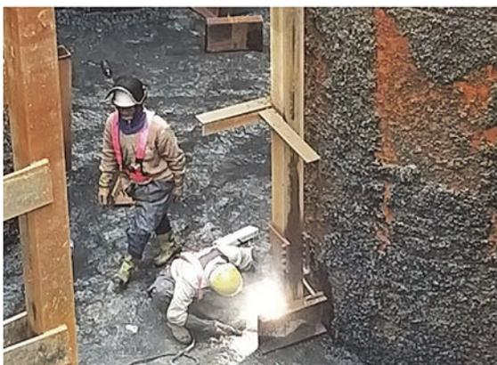
圖 12(a) 反壓托架銲接
