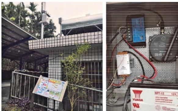
圖 5 豐丘國小雨量站採用 LoRa 通訊架構
