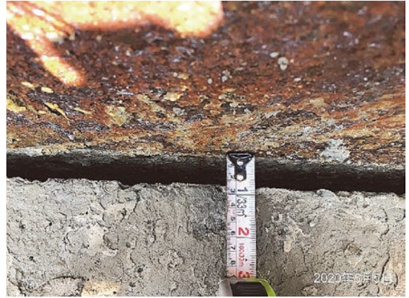
圖 14 鋼箱側模變位情形
