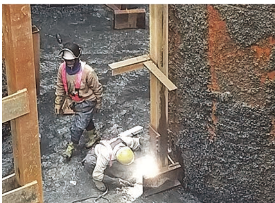
圖 12(a) 反壓托架銲接
