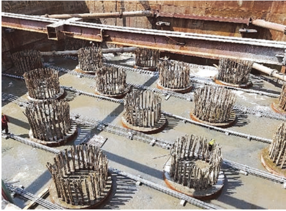
圖 13 鋼箱圍堰工作面樁頭處理完成情形
