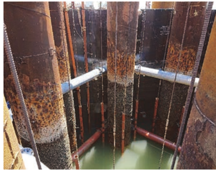
圖 11(b) 逐階抽水及臨時抗浮支撐施工
