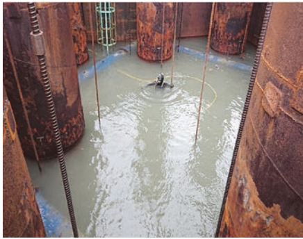
圖 11(a) 水下確認澆置成果
