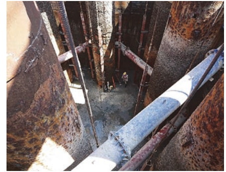
圖 11(c) 抽水及臨時抗浮轉換完成
