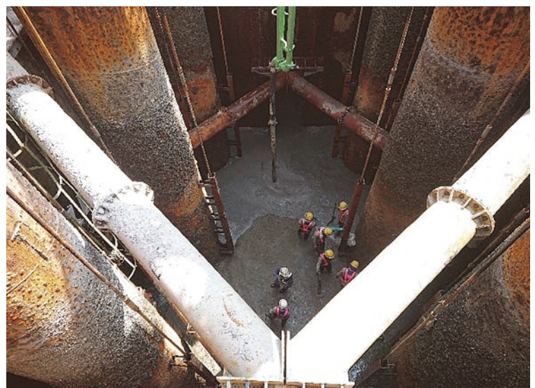
圖 12(b) 第二次封底澆置
