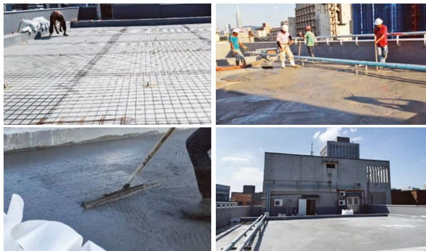
圖 13 無機聚合砂漿在北科大設計館屋頂防水工程施工及完工情形
