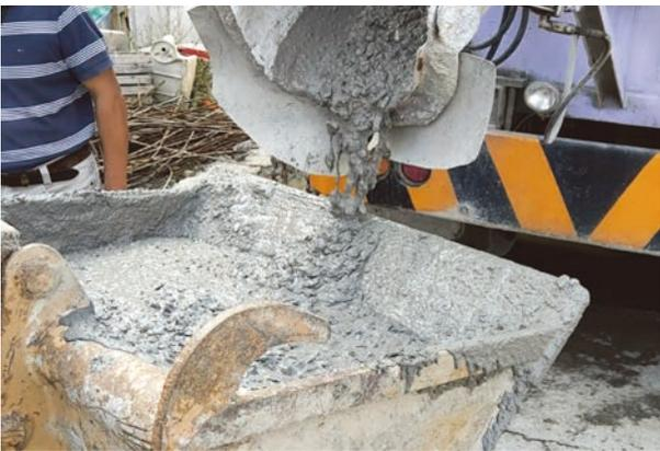
圖 2 無機聚合混凝土由預拌車卸至挖土機挖斗預備澆置 (攝於 2017/10/6)
