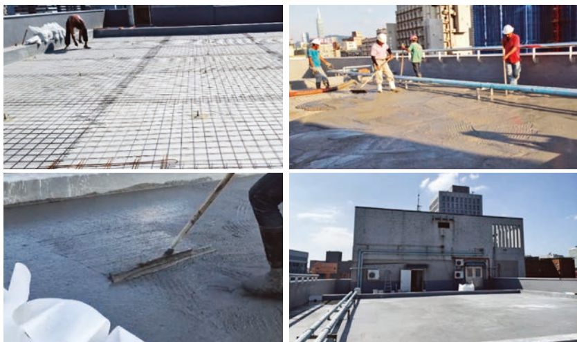
圖 13 無機聚合砂漿在北科大設計館屋頂防水工程施工及完工情形
