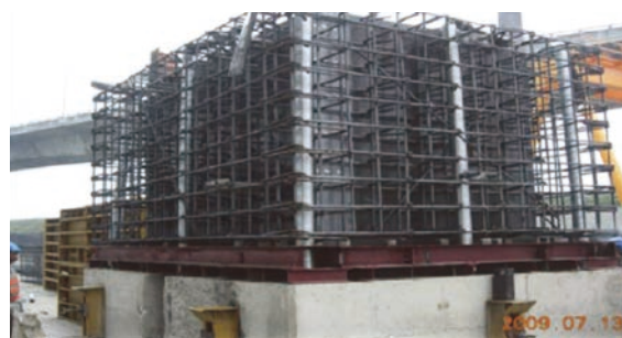
d. 現地施作預鑄節塊
