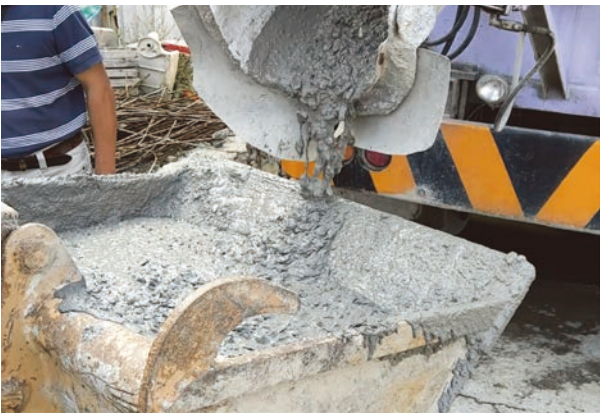
圖 2 無機聚合混凝土由預拌車卸至挖土機挖斗預備澆置 (攝於 2017/10/6)
