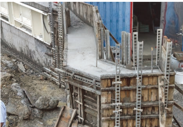
圖 3 無機聚合混凝土澆置完成的牆體 (攝於 2017/10/6)
