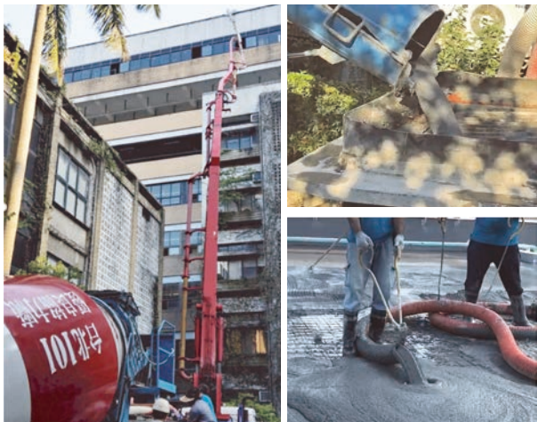
圖 11 無機聚合砂漿在北科大現場泵送情形
