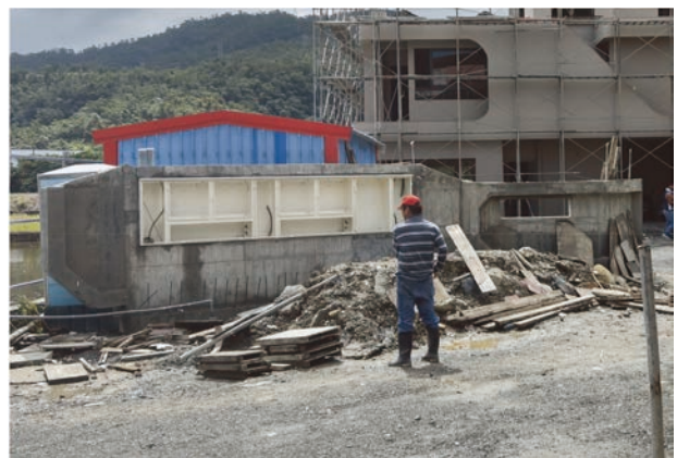
圖 4 無機聚合混凝土牆體拆模後情形 (攝於 2017/10/28)
