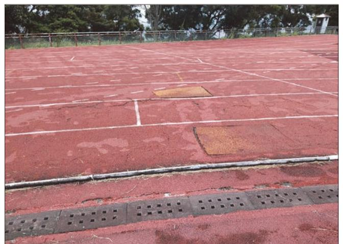
圖 16 點位 1 邊坡上方操場產生龜裂
