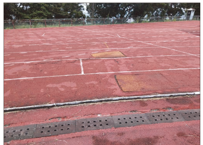
圖 16 點位 1 邊坡上方操場產生龜裂
