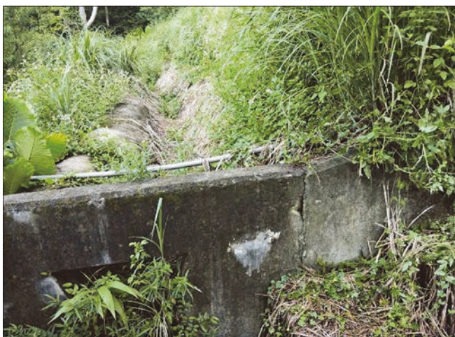
圖 14 圖 13 中點位 3 之構造物裂縫
