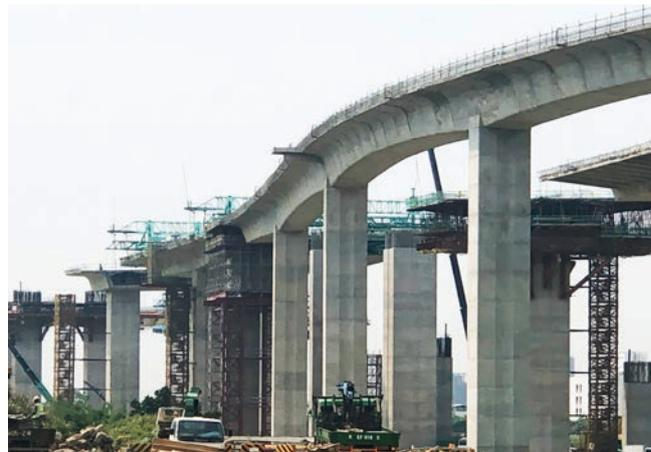
台中國四延伸綫工程：目前公共工程需備大量施工機具，本工程橋高達 46 公尺，同一區域有 24 組工作車，上下交錯一起施工。
