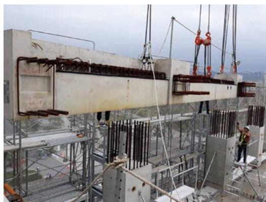
遠揚營造新建中的 27 層住宅大樓，位於板橋亞東醫院南側，採用第三代 RC 全預鑄（蓮根梁）工法。其特色是所有接頭不設在鋼筋交錯的柱頂，每層目標在五天到七天完成。現場有如樂高積木遊戲。
