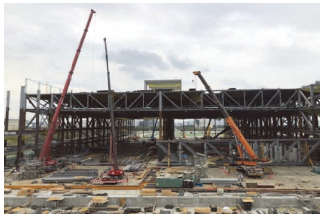
圖 25 高科技廠半導體房超大型桁架 (Truss) 結構
