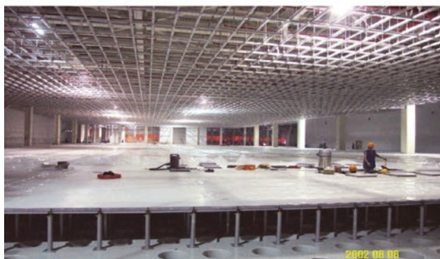
潔淨無塵室的施工
