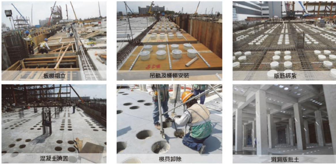
圖 15 Cheese Slab 的施工流程
