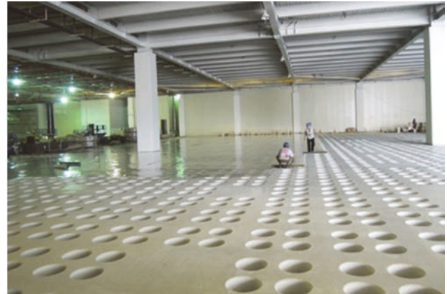
圖 7 無塵室內的洞洞板
