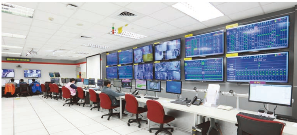
圖 3 廠務 FMCS 監控中心
