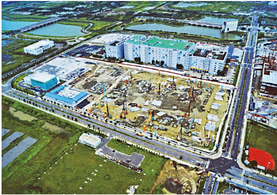
圖 14 南科下部結構施工照片
