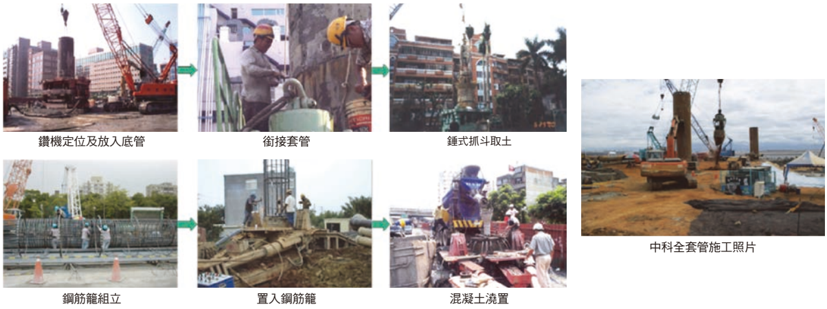
圖 18 全套管基樁工法示意
