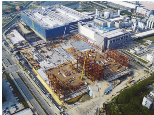
圖 24 上部結構施工動線及鋼構吊裝照片
