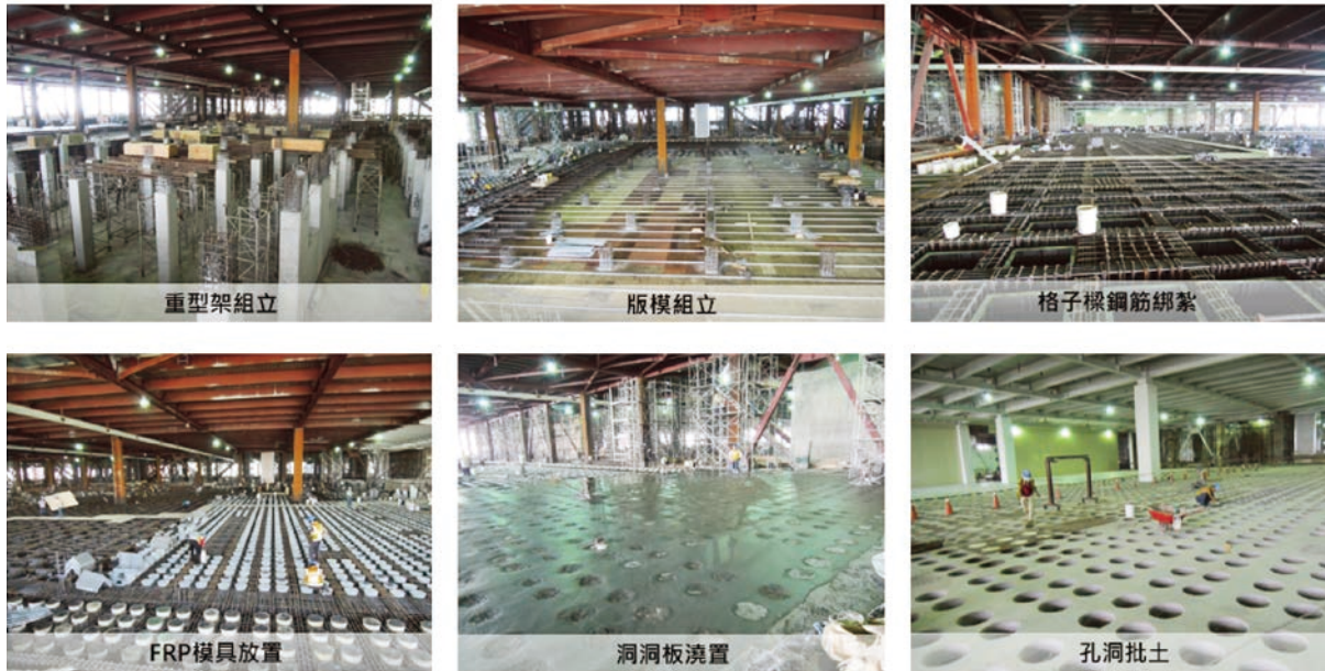
圖 18 Waffle Slab 的施工流程
