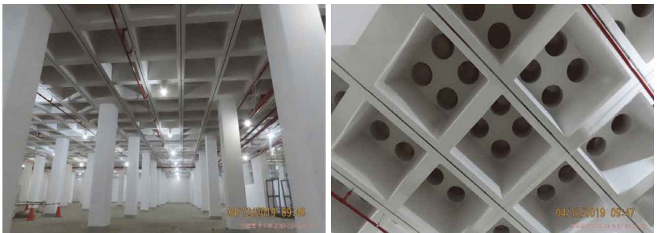
圖 17 Waffle Slab 下方模樣
