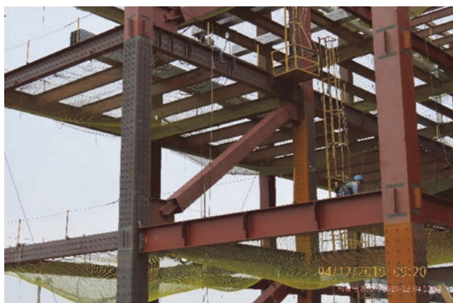
圖 24 BRB 現場安裝
