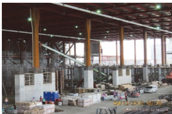
圖 19 高科技半導體廠房內的剪力牆
