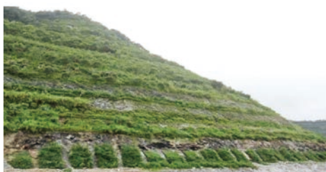
圖 16 植生土包綠化工法施工後
