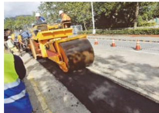
圖 17 面層鋪設作業
