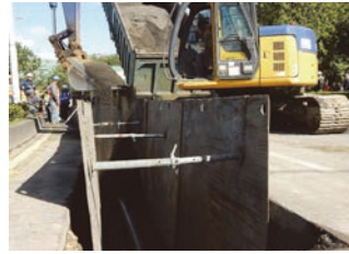
圖 11 管線埋設及保護層回填
