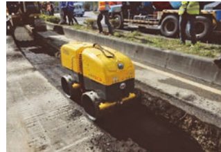
圖 13 回填層第一層回填及滾壓
