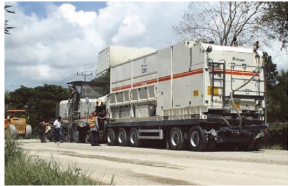
圖 3 濕式泵送方法及水泥稀漿設備
