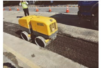
圖 14 回填層第二層回填及滾壓
