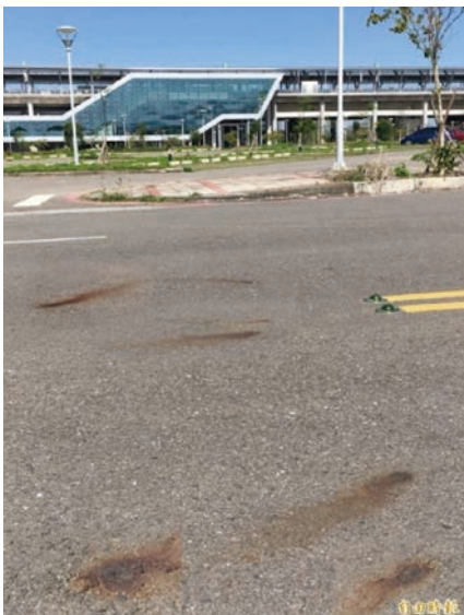
圖 1 過往道路工程產生明顯鏽斑（圖片引用自由時報）
