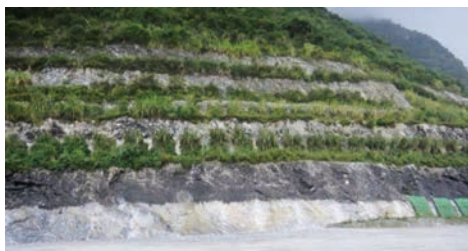
圖 15 植生土包綠化工法施工前
