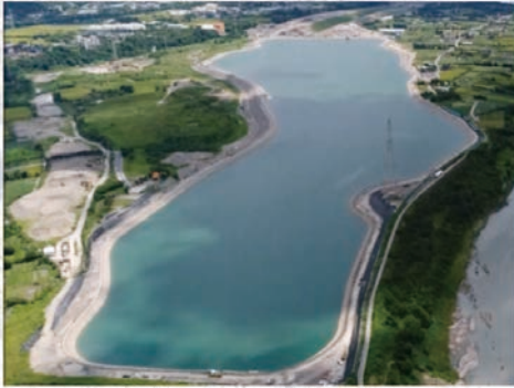
新建中庄調整池
