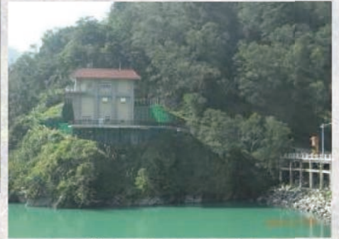
增設分層取水工
