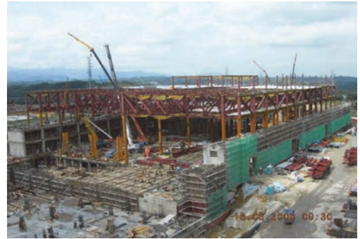
施工中的高科技廠結構工程 (栗正暉提供)
