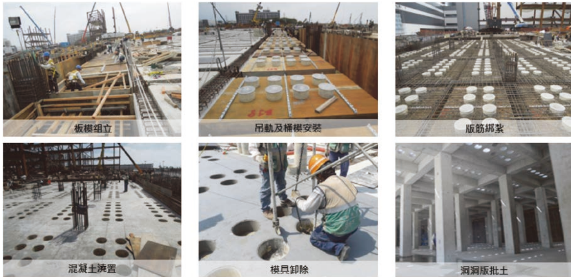
圖 15 Cheese Slab 的施工流程
