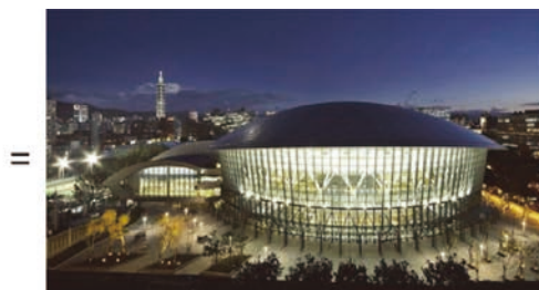
1座台北小巨蛋的鋼構用量
