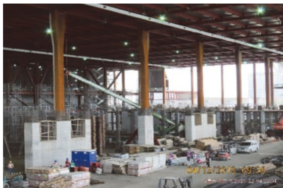
圖 19 高科技半導體廠房內的剪力牆
