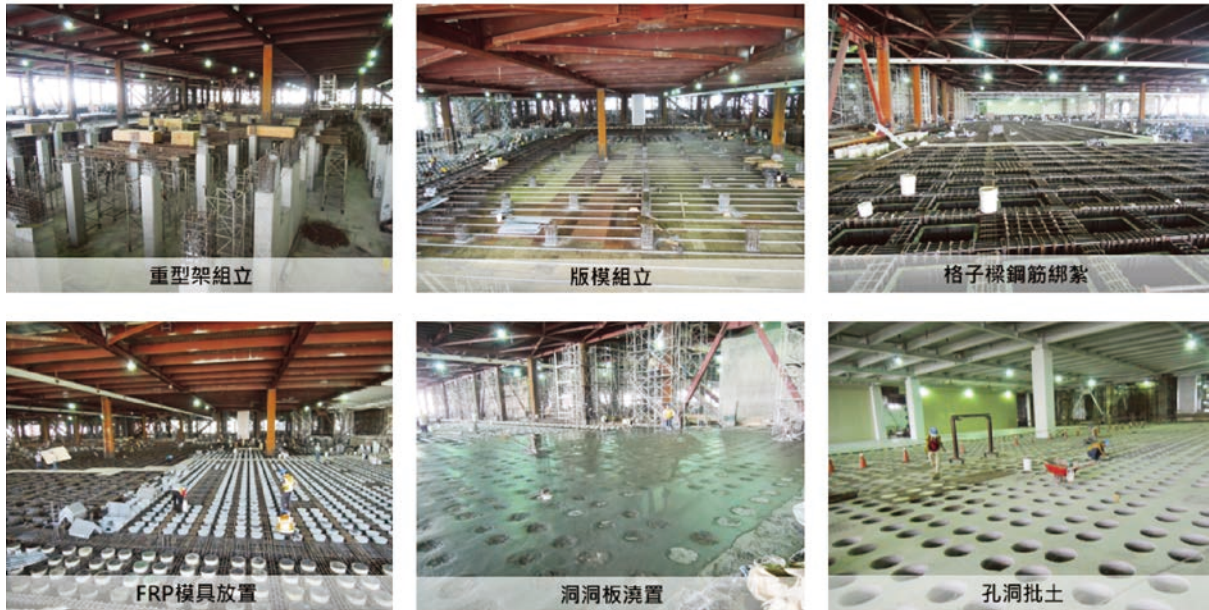
圖 18 Waffle Slab 的施工流程
