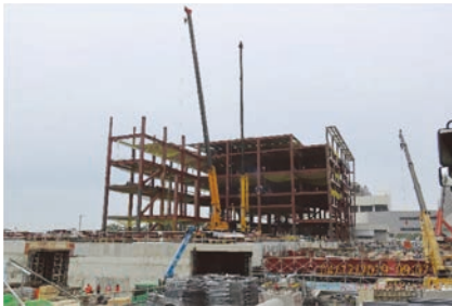
圖 10 CUP 鋼結構吊裝
