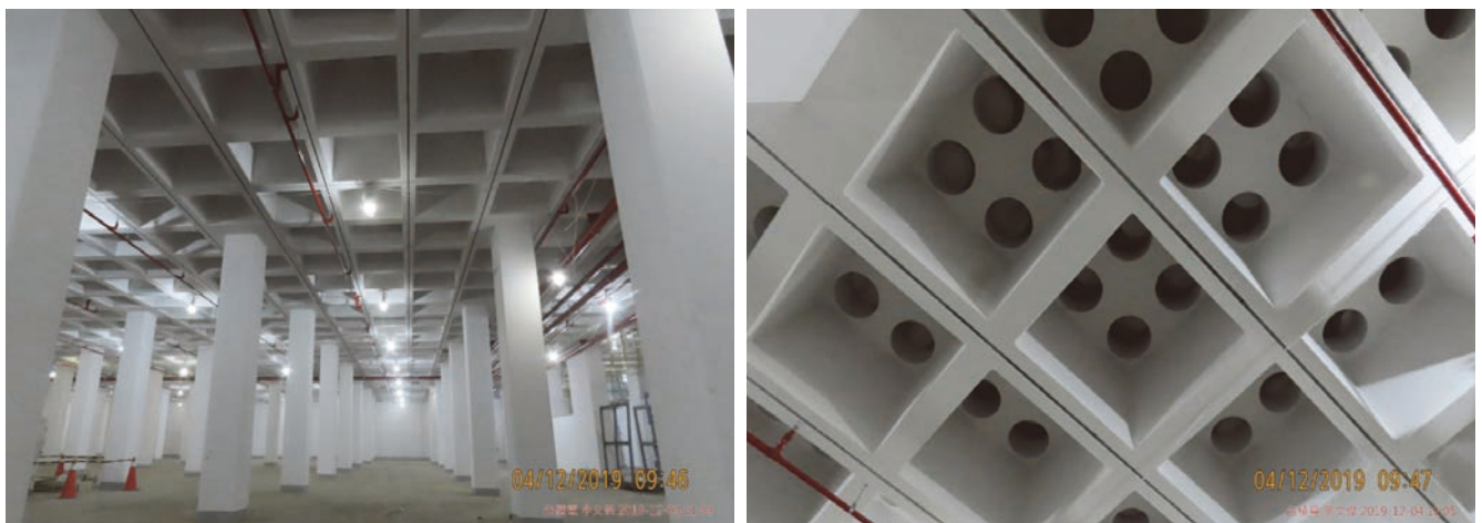
圖 17 Waffle Slab 下方模樣
