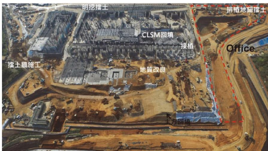
圖 17 中科下部結構施工照片
