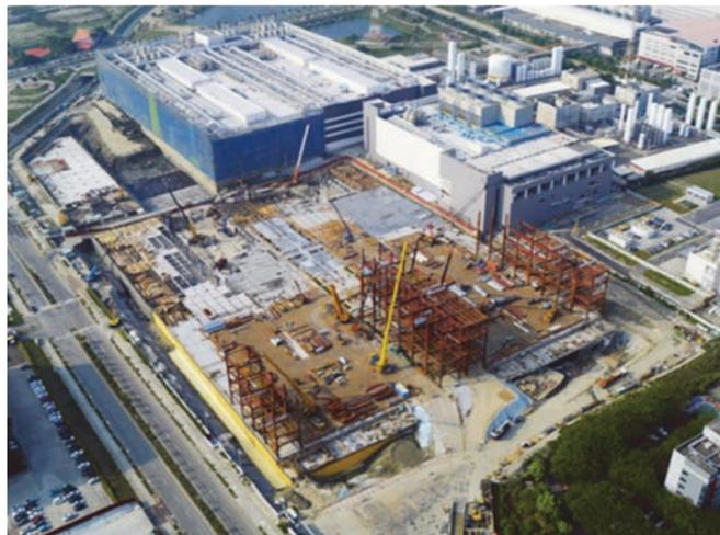
圖 24 上部結構施工動線及鋼構吊裝照片
