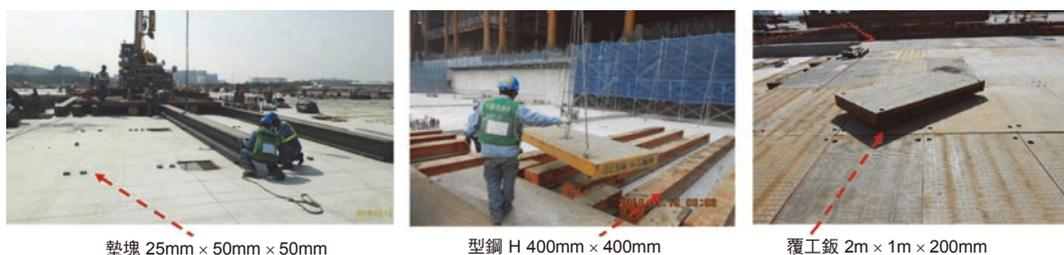
圖 23 覆工板鋪設示意
