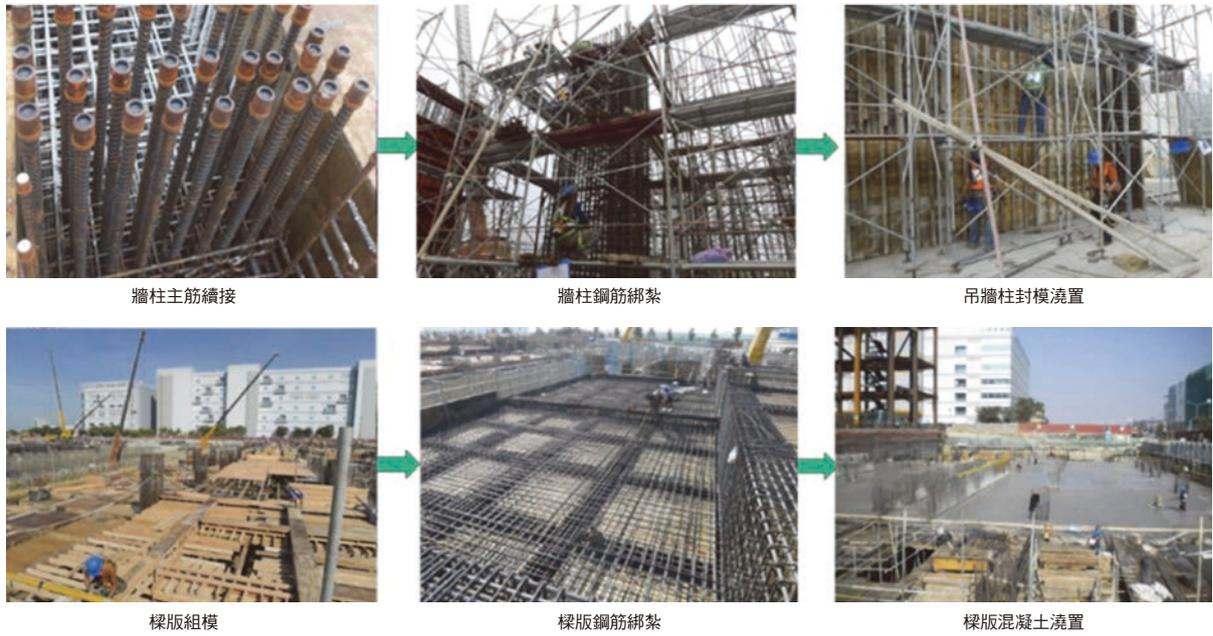
圖 19 地下室結構體施工流程示意
