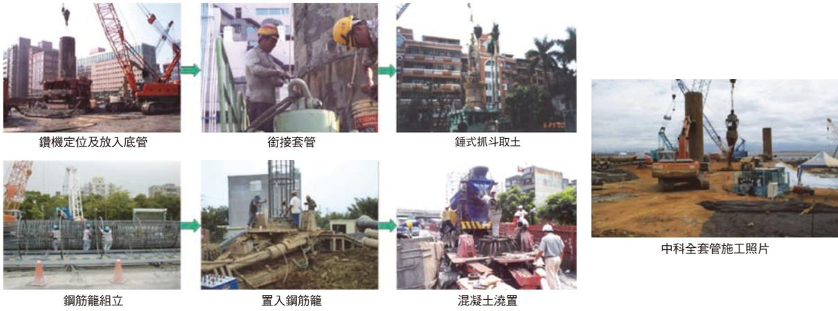
圖 18 全套管基樁工法示意
