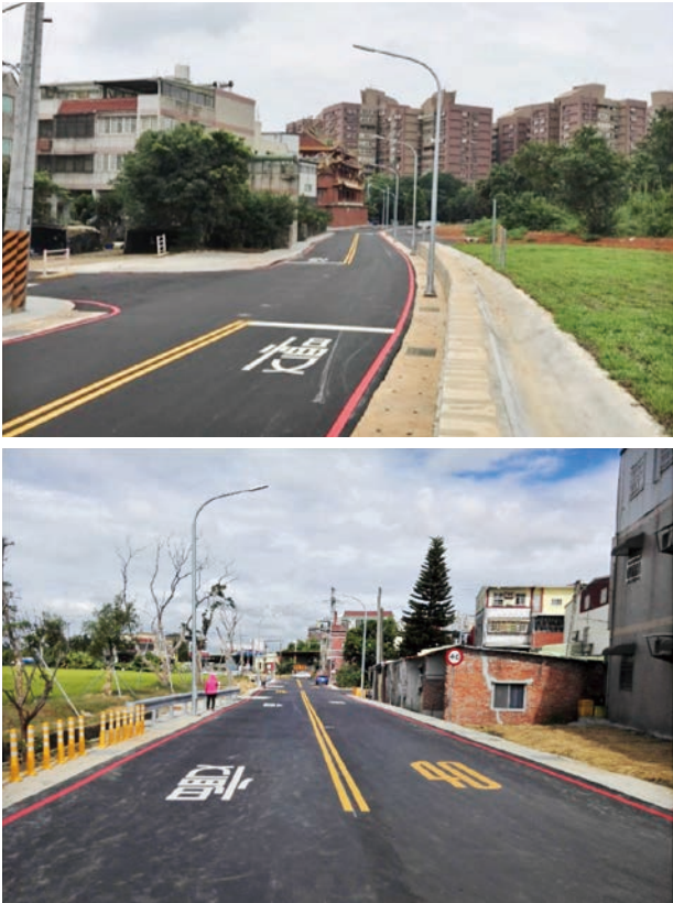
圖 8 五守街至福裕路改善工程(上)、華安街道路拓寬工程(下)運用刨除料之完工照片
