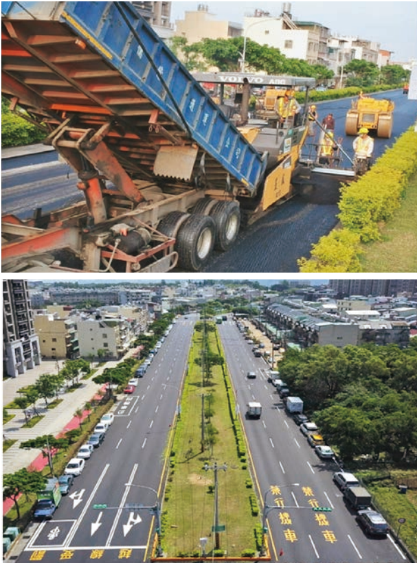
圖 5 桃園市八德區豐德路運用氧化礫之施工及完工照片
