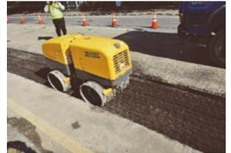
圖 14 回填層第二層回填及滾壓
