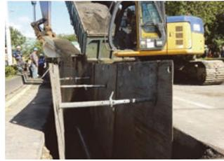
圖 11 管線埋設及保護層回填
