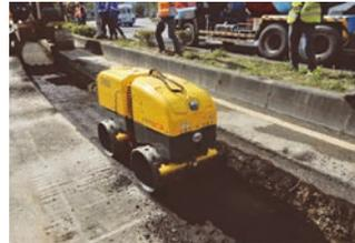
圖 13 回填層第一層回填及滾壓
