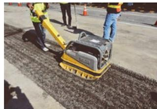
圖 15 回填層第二層表面壓平
