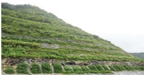
圖 16 植生土包綠化工法施工後
