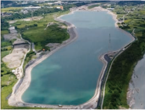
新建中庄調整池
