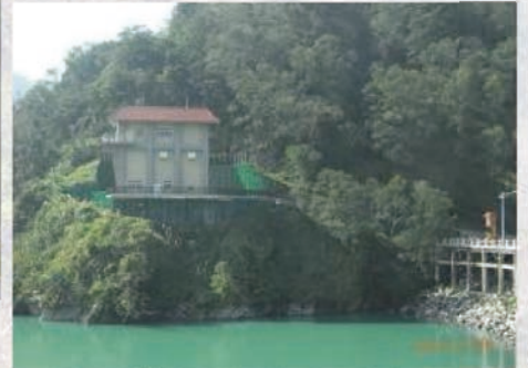
增設分層取水工
