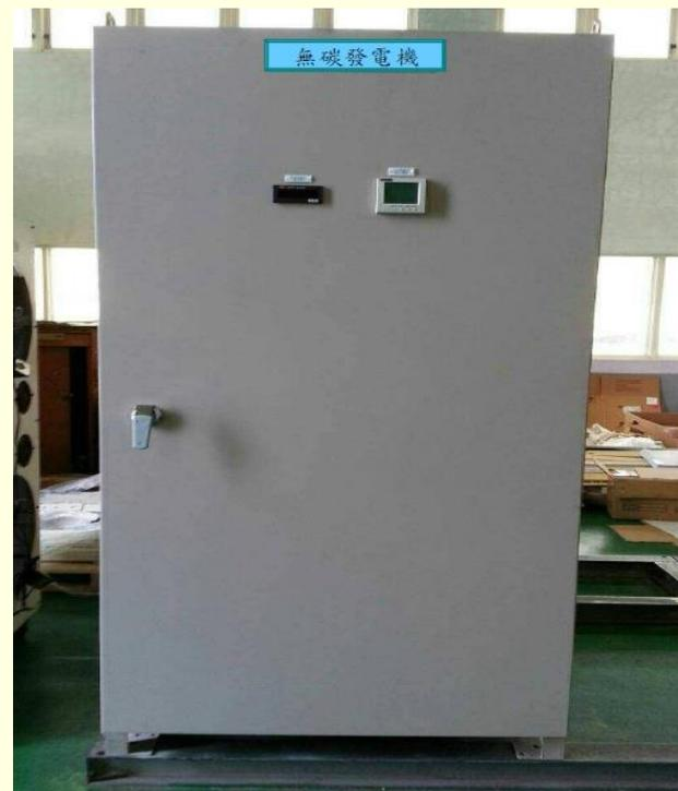
規格：可客製化發電機系統240kw( 3相/220/380/440/600VAC) 資料來源：陳炯蒿先生提供
