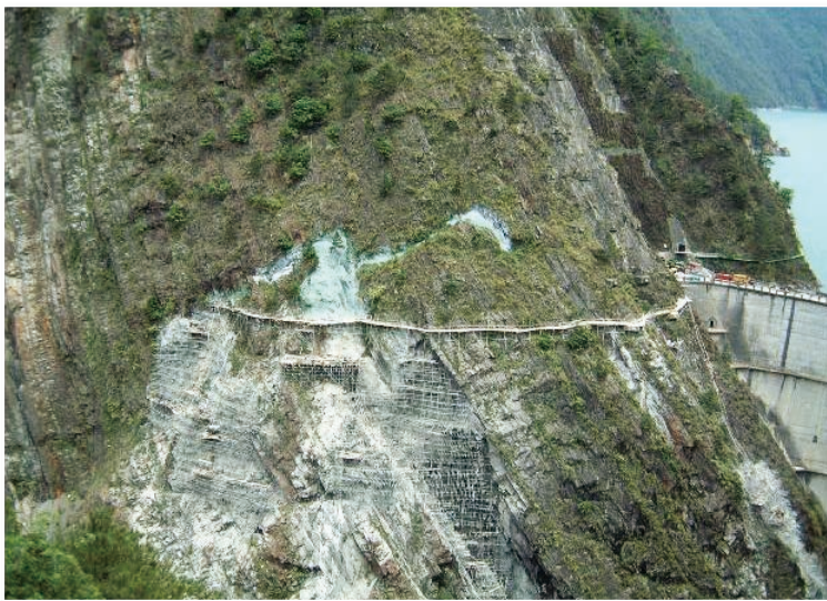
台電德基水庫大壩
