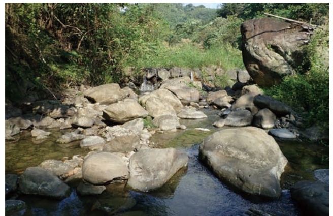
圖 4 第五期整治工程以近自然的生態工法建構
