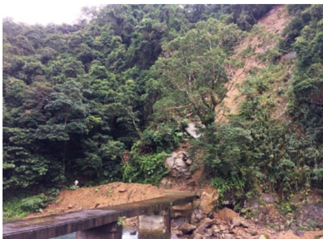
相片 2 崩場地治理工區的大葉楠
