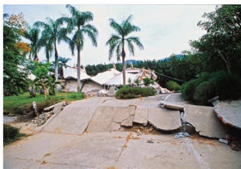
在下盤觀察逆斷層與上盤的北棟建築
