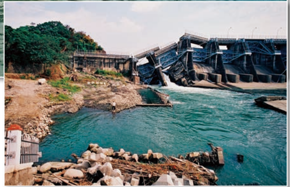
大甲溪石岡壩因車籠埔斷層錯動而破壞
