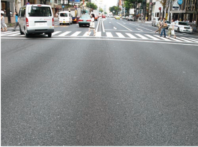
圖 9 日本東京街道的透水鋪面（洪如江攝）
