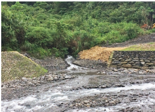
相片 1 出水溪護岸開缺口（動物通道）
