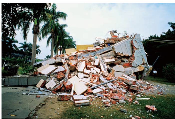
光復國中北棟建築東端倒塌
