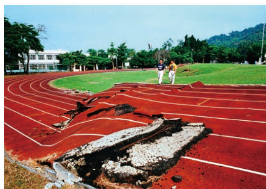
操場南跑道之處，由斷層上盤俯視下盤
