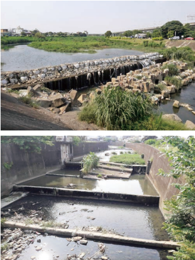
圖3 下埤圳攔水堰（上）與林厝排水固床工（下）現況
