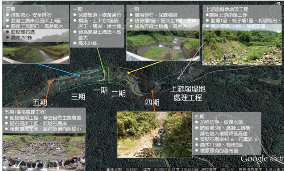
圖 2 頓阿巴娜野溪各期整治工程位置、明細與現場概況
