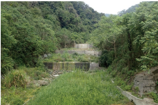
圖 3 第一期至第三期整治工程是負控制組，以傳統工法施作
