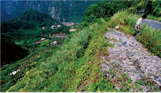
圖 48 在鐵線腐爛之前，藤類植物接力保護（洪如江攝）
