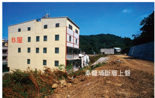
圖 32 九二一地震時，車籠埔斷層交會的房屋，B 屋因基礎堅強而安然無恙（洪如江攝於豐原市中正公園）
