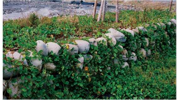
圖 49 彰化海邊的磊石矮牆，以藤類植物網捆綁之，越久越強（洪如江攝）
