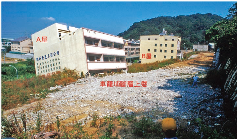
圖 30 九二一地震時，車籠埔斷層交會的房屋，A 屋嚴重歪斜，B 屋因基礎堅強而安然無恙（洪如江攝於豐原市中正公園）
