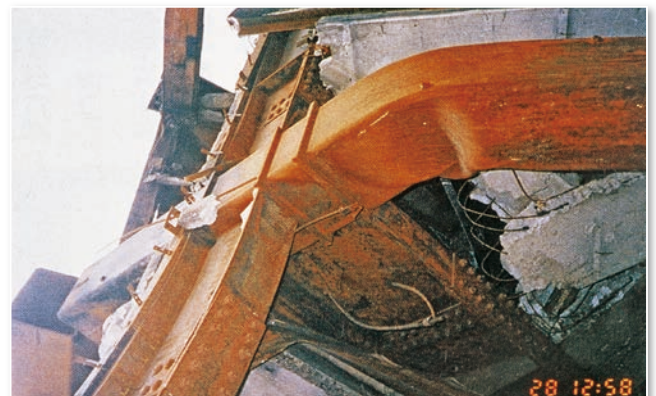
圖 35 在極端的災害作用下，韌性材料所建造的韌性結構會損傷，但不會崩潰（陳生金教授提供）
