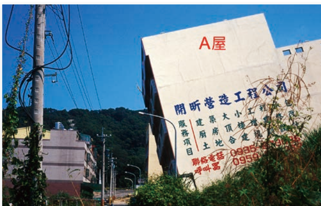
圖 31 九二一地震時，車籠埔斷層交會的房屋，A 屋嚴重歪斜（洪如江攝於豐原市中正公園）
