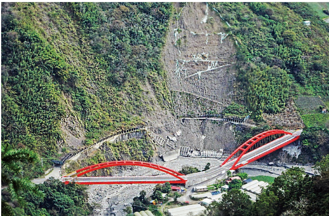
圖 15 南投縣東埔日月雙橋及毀損明隧道
