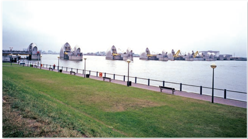
圖 20 英國泰晤士河防潮閘 (Thames Barrier) 全景 (洪如江攝)
