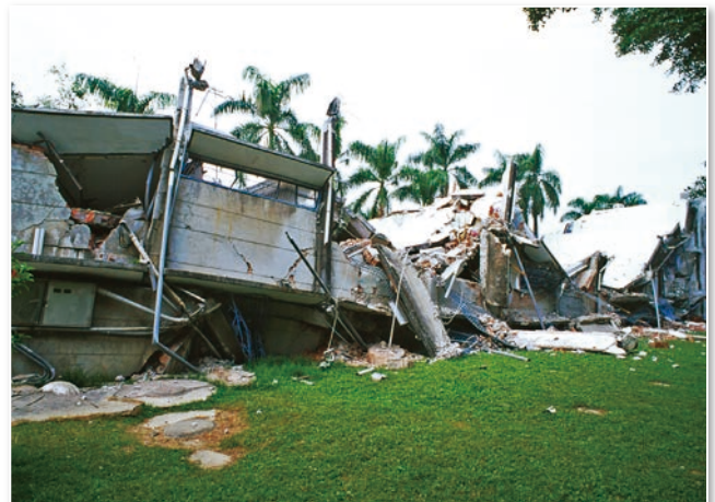
圖 38 台中霧峰光復國中校舍建築於九二一地震時倒塌的情況（洪如江攝）
