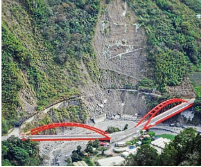
南投縣東埔日月雙橋及毀損明隧道
