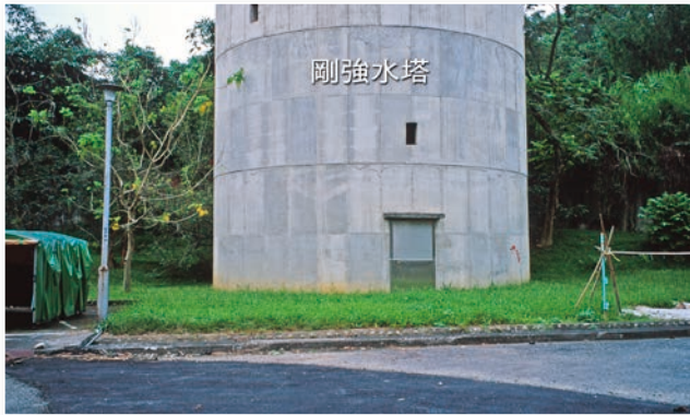
圖 33 台灣九二一地震，車籠埔斷層在中興新村與一剛強水塔交會，繞道而過，水塔安然無恙（洪如江攝）
