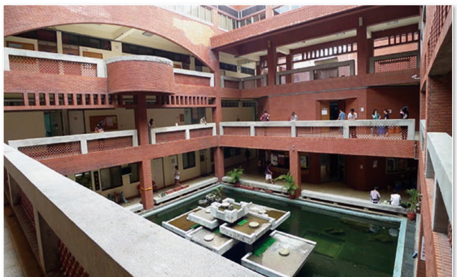
圖 2 中央大學綜教館各樓層環繞迴廊，有利於陽光照射及通風 (洪如江攝)
