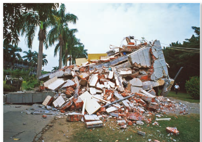
圖 39 台中霧峰光復國中校舍建築於九二一地震時倒塌的局部（洪如江攝）
