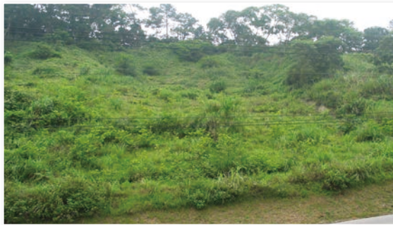
圖 50 崩塌之路坡以植物修復保護之（台三線公路）（洪如江攝）
