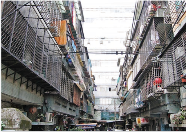
圖 13 台灣城市住宅區的鐵窗文化：住宅監獄化（洪如江攝）
