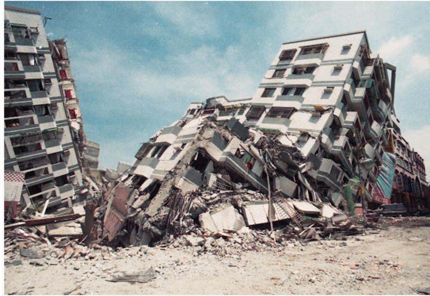
圖 41 台灣九二一地震，樓房倒塌近照 (歐陽一先生攝)
