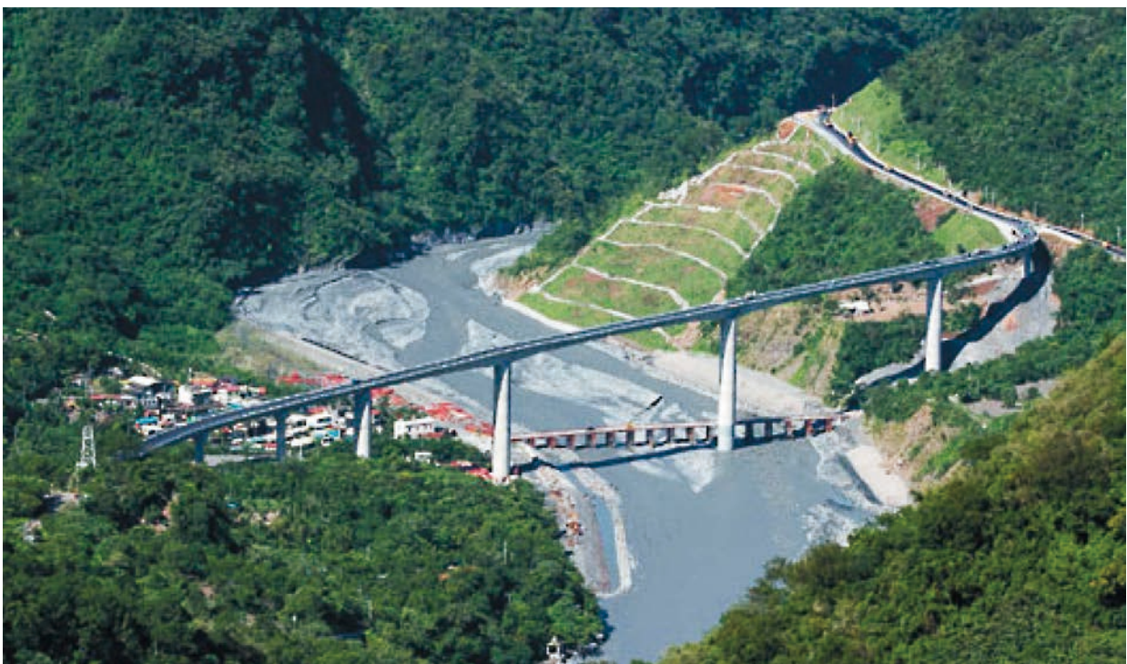
圖 12 長跨高橋墩霧台谷川大橋
