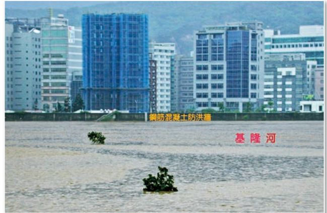
圖 25 大直防洪牆的防洪效果（李錫堤教授攝）
