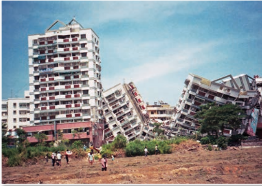
圖 40 台灣九二一地震，樓房倒塌之例 (歐陽一先生攝)
