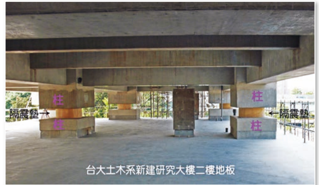
圖 34 台大土木系新建研究大樓在二樓裝置隔震墊，隔絕經由基礎及一樓上傳的地盤震動（洪如江攝）
