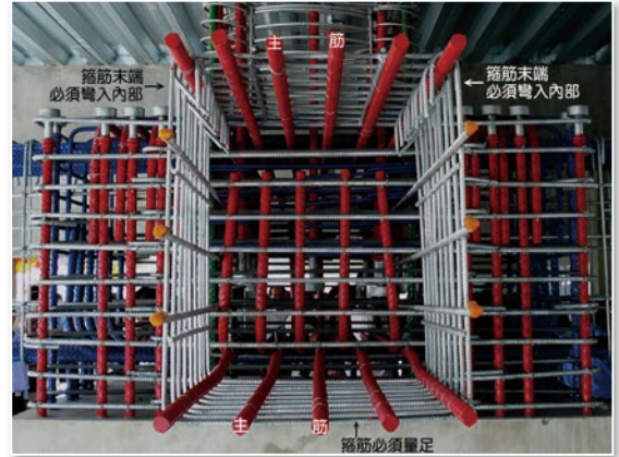
圖 37 鋼筋混凝土構件（柱或梁）中的鋼筋組構（洪如江攝）
