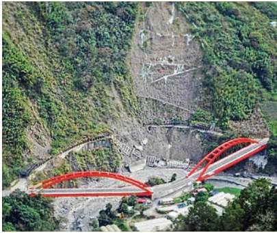
南投縣東埔日月雙橋及毀損明隧道
