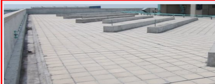
「日常節能」：屋頂版以PS隔熱磚與PU膜施作使建築物外殼的熱傳透率降低
