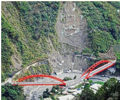
南投縣東埔日月雙橋及毀損明隧道
