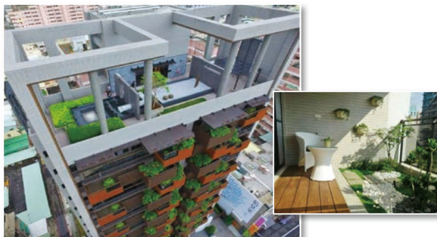
圖 4 建築物屋頂與立體綠化 (資料來源：高雄市政府工務局，2018)
