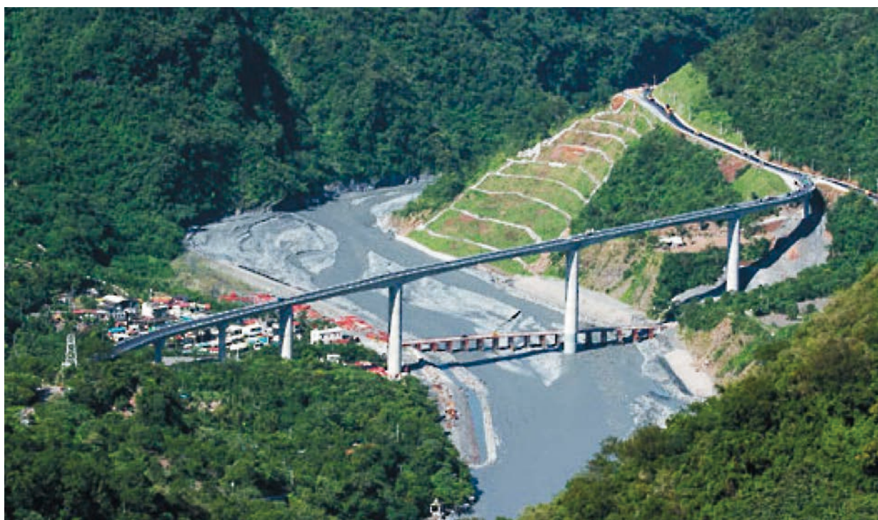
圖 12 長跨高橋墩霧台谷川大橋
