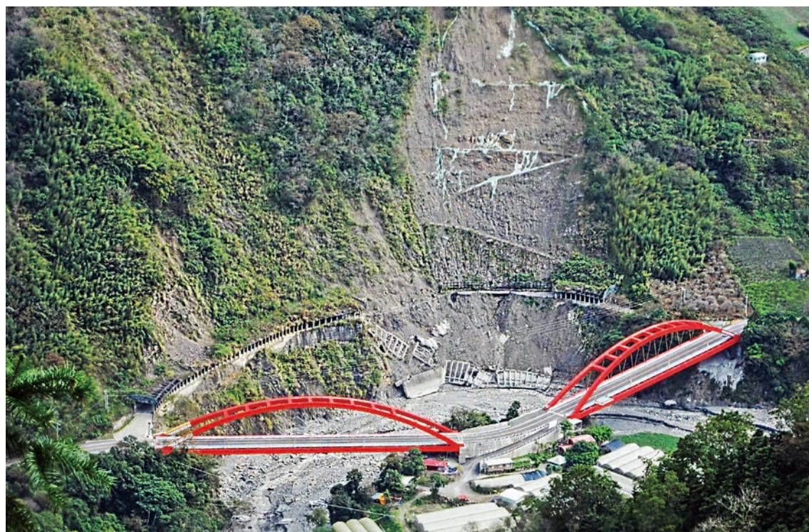
圖 15 南投縣東埔日月雙橋及毀損明隧道
