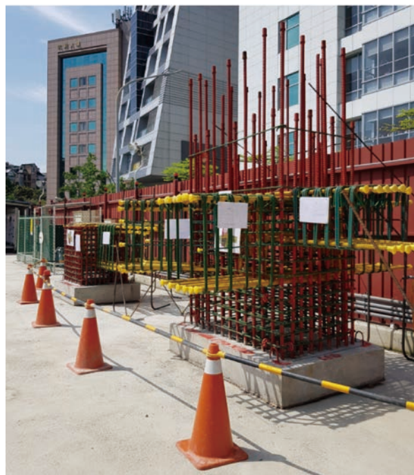
圖 27 比例 1:1 鋼筋梁柱接頭樣品
