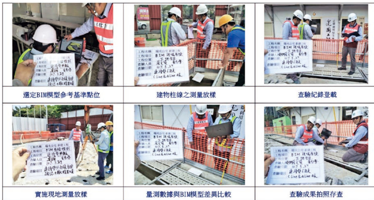
圖 33 BIM 模型放樣檢測圖示
