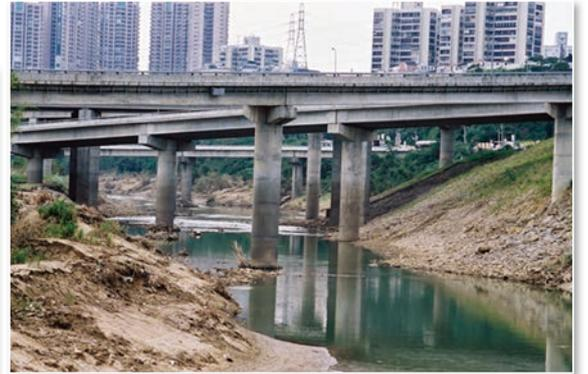
圖 28 汐止下游的基隆河狹窄河道塞入許多橋墩（洪如江攝）
