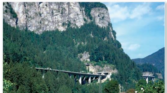
圖 20 瑞士山區道路多採棧橋與隧道以避免大挖大填（洪如江攝）
