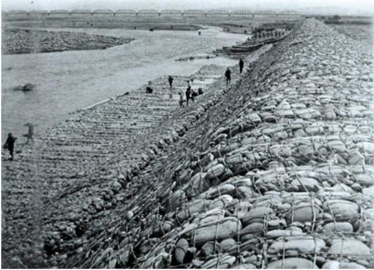
圖 11 濁水溪石砌堤防上鋪鐵線蛇籠工事築設一景(《主要工事寫真帖》1916 年左右)
