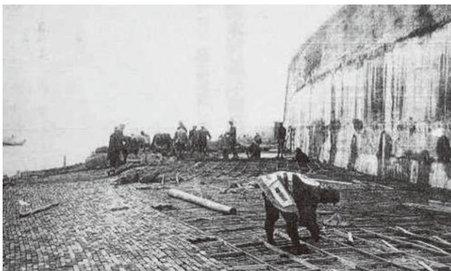
圖 5 淡水河堤防串磚沉床工程施工（《台灣に於ける鐵筋混凝土構造物寫真帖》1914年）
