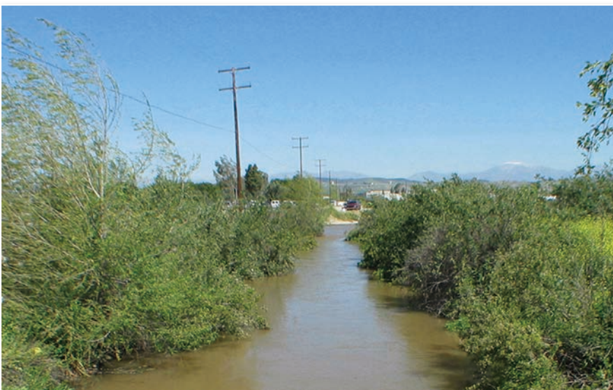
圖 41 美國加州桔郡的一條渠道，以植物護岸（洪如江攝）
