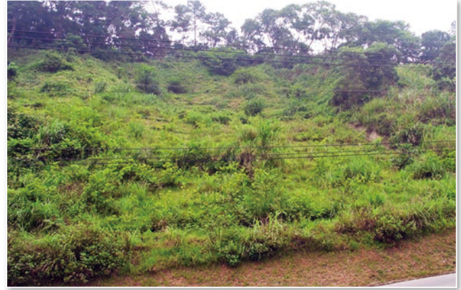
圖 40 台三線公路崩坍之路坡以植物修復保護之，時間越久路坡越穩定（洪如江攝）
