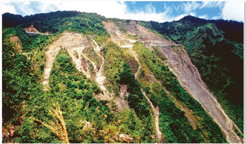
圖 15 新中橫公路水里玉山線東埔段大迴頭彎路坡崩坍（洪如江攝）
