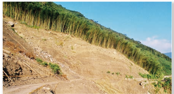
圖 17 石門水庫集水區開闢公路（桃 113 線）之後，在邊坡搶種淺根作物竹子，極易因豪雨或地震而坍塌（洪如江攝）
