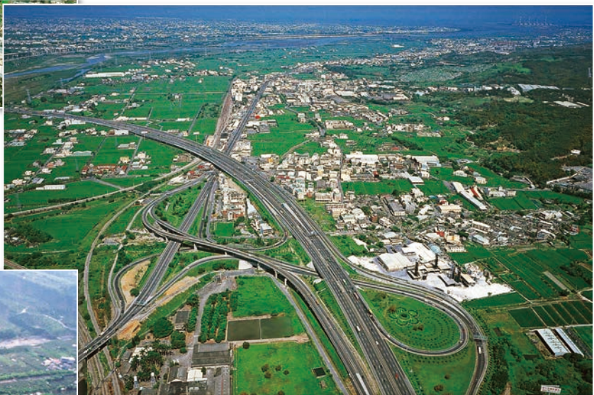
圖6 交流道將生物棲地切割得支離破碎 (連永旺先生攝)
