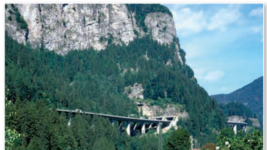
圖 20 瑞士山區道路多採棧橋與隧道以避免大挖大填（洪如江攝）
