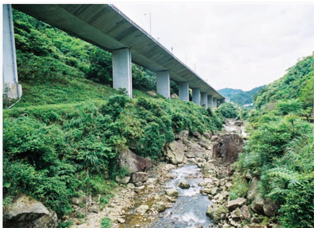
圖 19 北宜高速公路採用棧橋，避免大挖大填，對環境衝擊小（洪如江攝）
