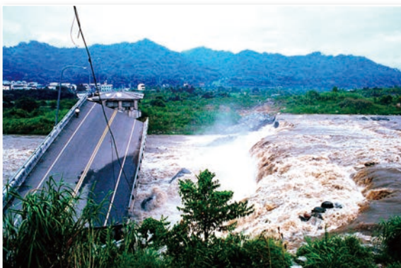
圖 23 車籠埔斷層在大甲溪逆衝隆起，埤豐橋塌落中 (洪如江攝)
