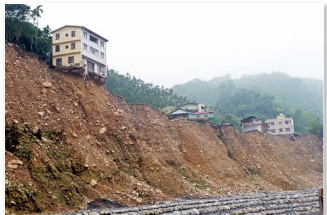
圖 27 陳有蘭溪東岸公路及其臨溪所有房屋, 在莫拉克颱風豪雨災害全面崩坍失蹤(洪如江攝)
