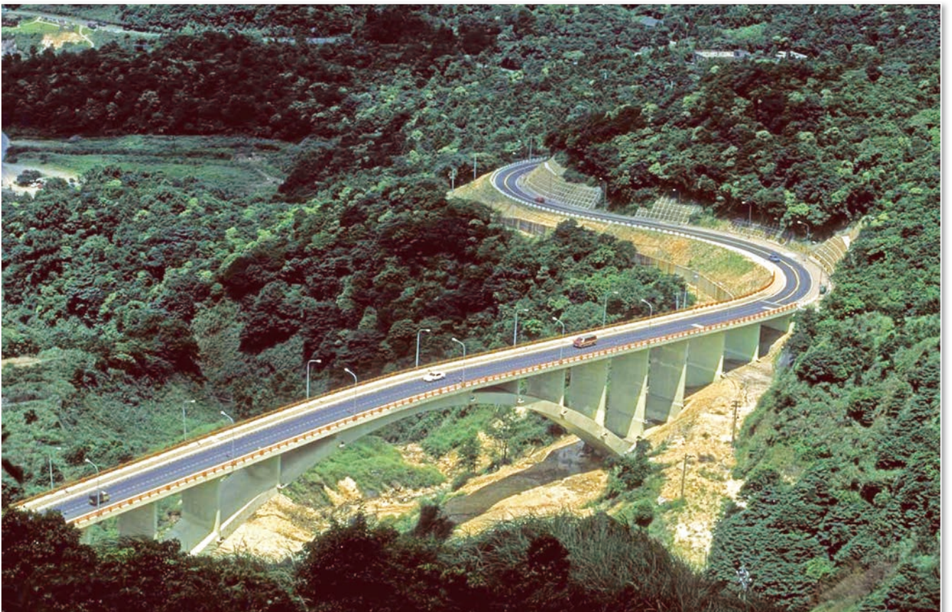
圖 30 新馬槽橋之橋孔夠高夠寬不妨礙土石流通過（中華顧問工程司提供）
