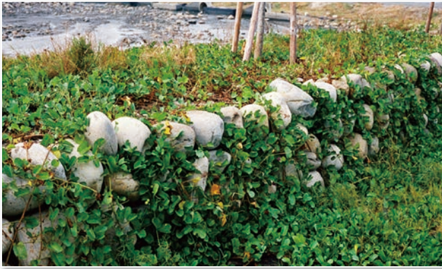
圖 39 彰化海邊的磊石矮牆，種植藤類植物捆綁之，越久越強（洪如江攝）
