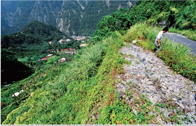
圖 38 蛇籠在鐵線腐爛之前，藤類植物接力保護，蛇籠隨時間而變得更粗更強壯（洪如江攝）
