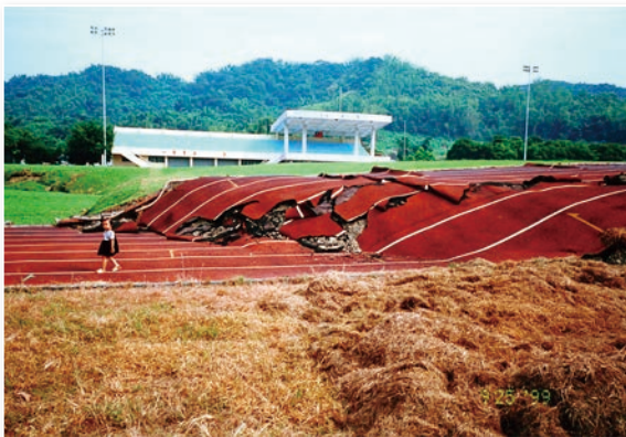
圖 21 九二一地震時，車籠埔斷層在光復國中操場逆衝所造成的奇觀 (洪如江攝)
