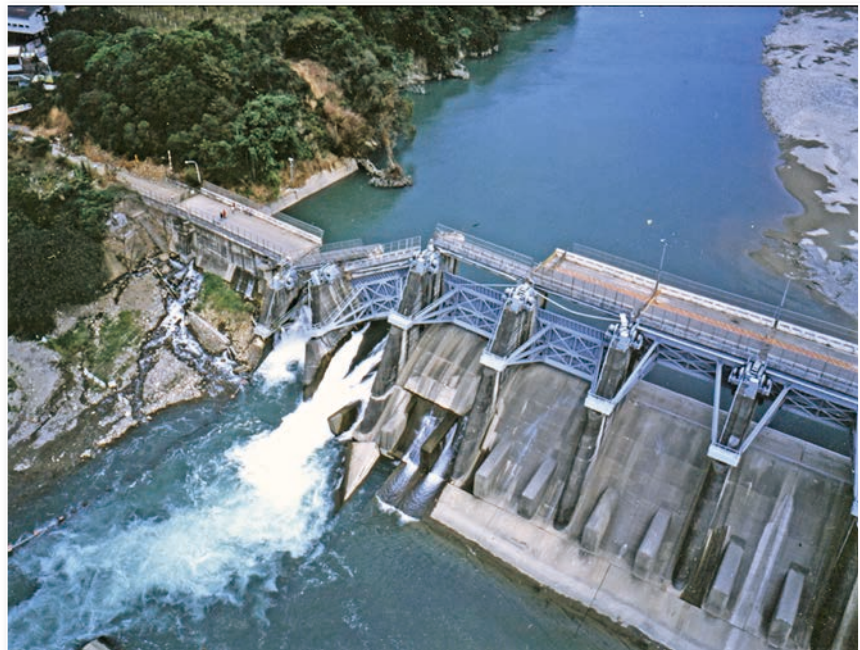
圖 22 九二一大地震石岡壩破壞 (連永旺先生攝)
