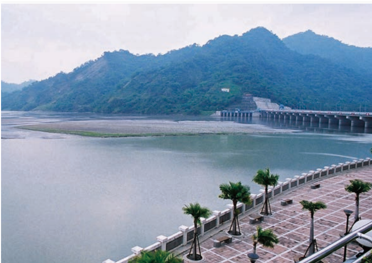
圖 31 集集攔河堰淤積大量泥沙，減少下游泥沙供應（洪如江攝）
