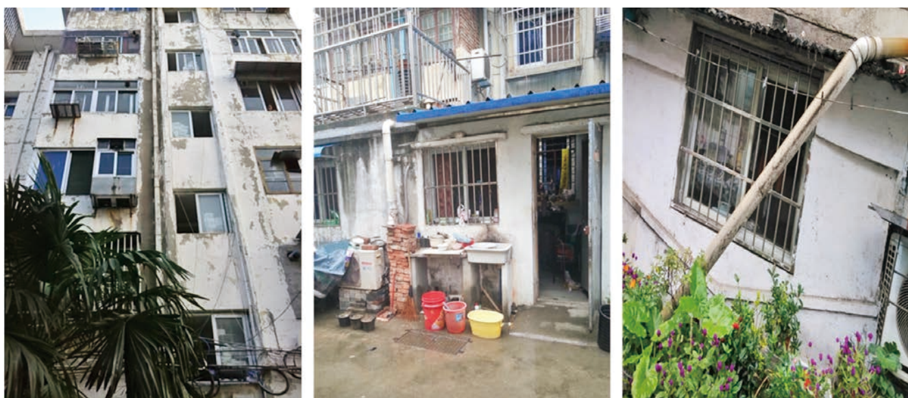
圖 3 江濱新村二區改造前基礎設施破舊、雨水污水管道混接普遍
