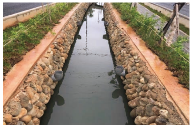
桃園蘆竹市宏竹里大華北街道路改善工程
