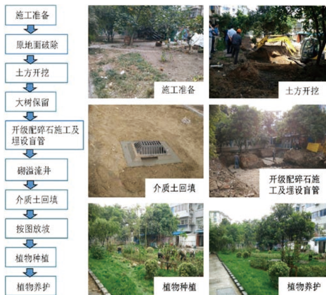
圖 13 雨水花園施工過程
