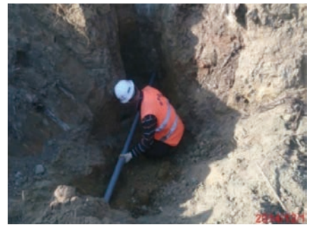
(c) 設置 PVC 透水管
