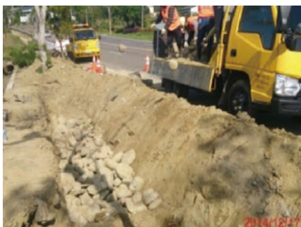
(d) 底部回填礫石層
