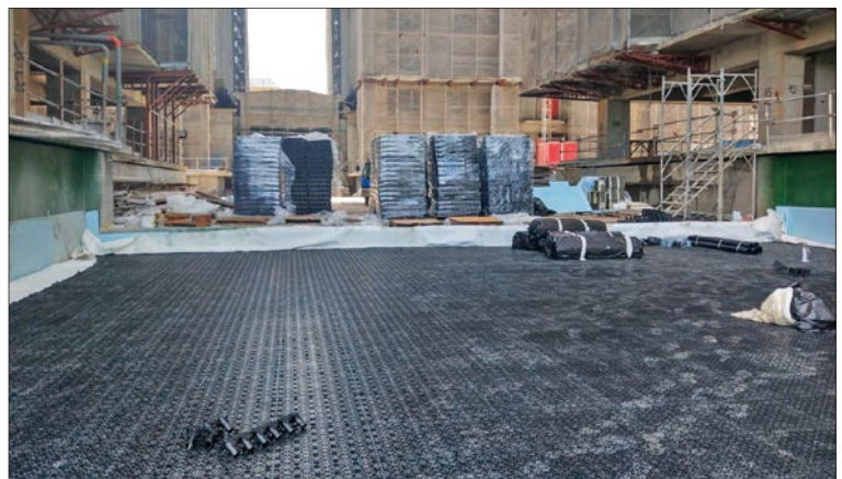
圖7 薄層集水應用 （圖來自築綠生態有限公司）
