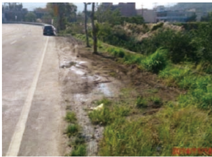
(a) 施工前現況
