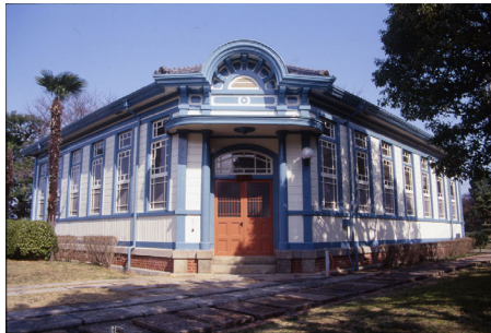
原・御殿浄水場管理辦事處（香川県高松市：1917） 現・水道資料館 / 国登録有形文化財
