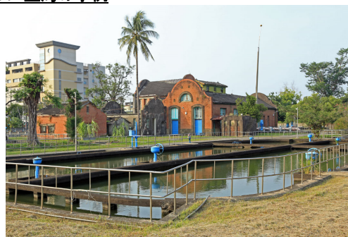
竹寮抽水站（高雄市：1913）
