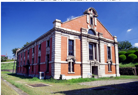
鍋屋上野浄水場第1唧筒站（名古屋市：1914） 設計：栗山俊一（臺北郵局の設計建築家） 名古屋市指定文化財
