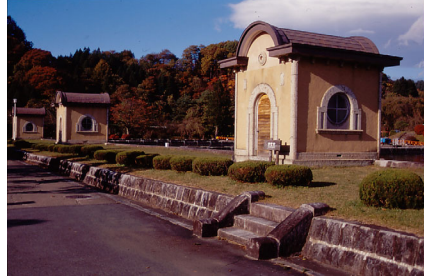
米内浄水場（岩手県盛岡市：1934）/国登録有形文化財
