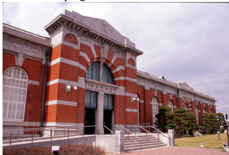
原・柴島浄水場唧筒房（大阪市：1914） 現・水道記念館/ 国登録有形文化財
