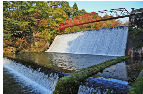
藤倉水源地（秋田県秋田市：1911）/ 国重要文化財
