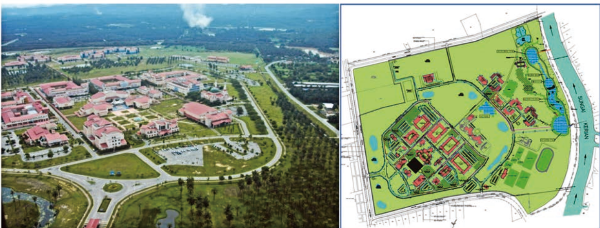
Fig. 3 Aerial View of USM Engineering Campus 馬來西亞理科大馬工程系分院
