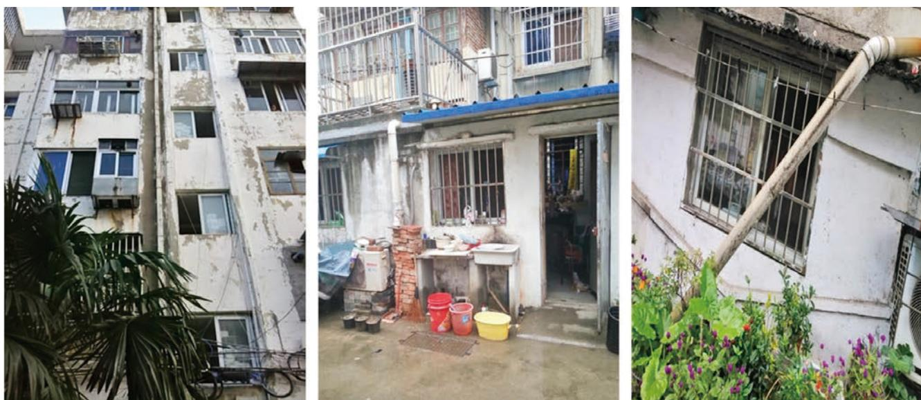
圖 3 江濱新村二區改造前基礎設施破舊、雨水污水管道混接普遍
