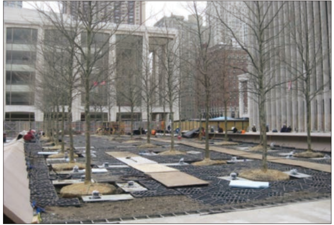
圖 10 樹穴結構模組 (來自 Silva Cell 官方網站)
