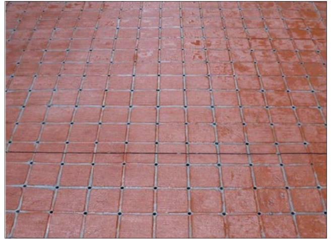
圖 2 管式透水鋪面應用於停車場
