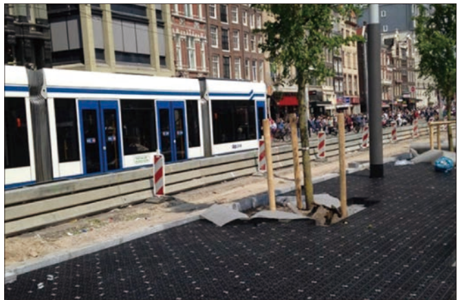
圖 12 塑膠蓄水貯集框架 (薄層集水) (來自 Permavoid 官方網站)
