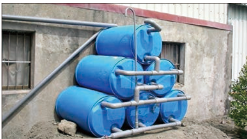
圖3 地上式雨水回收桶（嘉義縣環保局提供）
