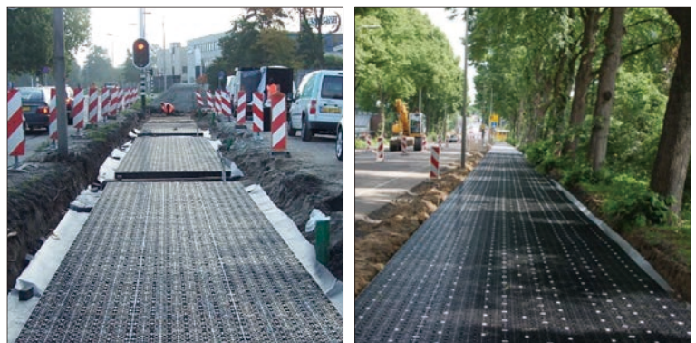
圖6 塑膠蓄水貯集框架（三明治結構）應用 （圖來自 Permavioid 官方網頁）
