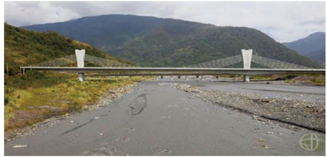
台9線蘇花改南澳北溪橋（跨徑 95 + 160 + 105 m）
