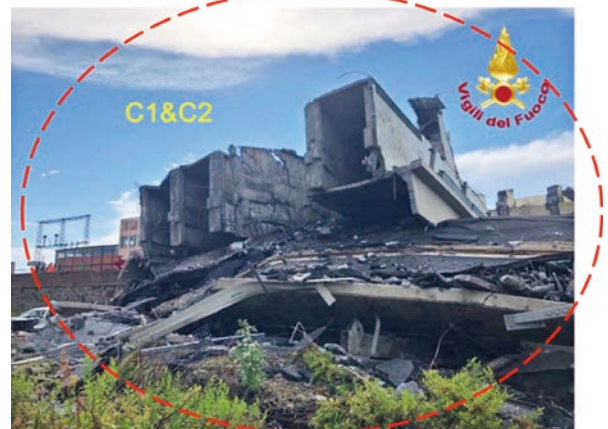
圖 17 橋梁倒塌 C 區照片 [15]
