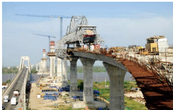
圖 7 哥倫比亞施工中的新 Pumarejo 大橋
