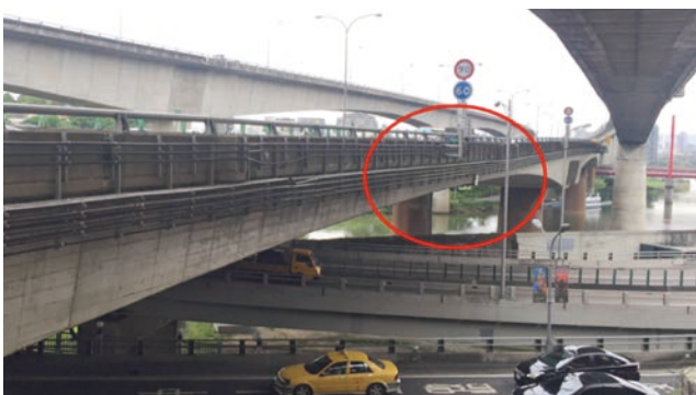
圖 10 國道 1 號圓山橋主跨中間鉸接處下垂現象 （陳振川教授簡報圖資）
