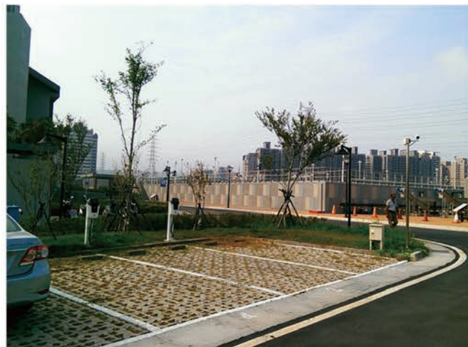
台中南屯文山水資源施工後
