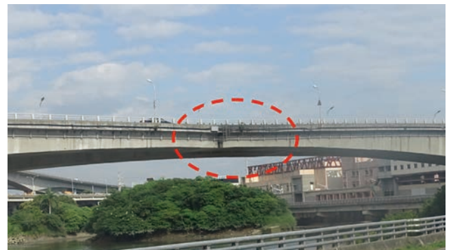
圖 11 台北市新生高架松江大橋主跨中間鉸接處下垂現象
