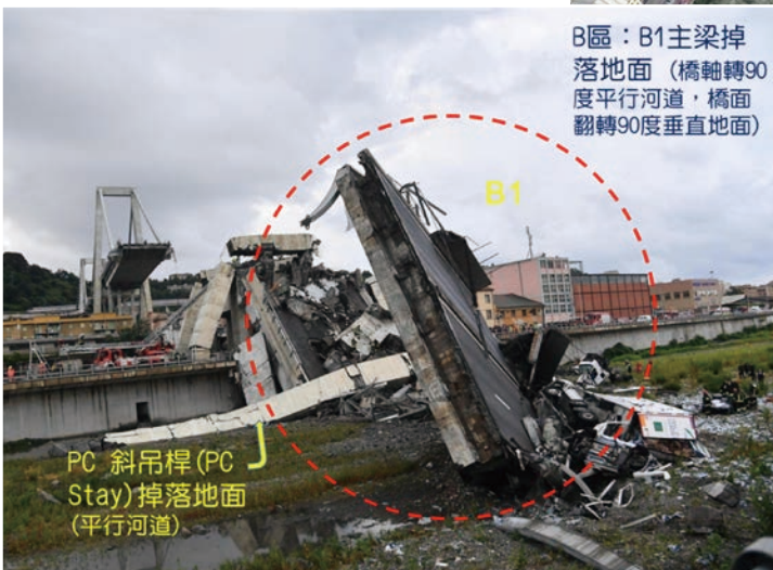
圖 16 橋梁倒塌 B 區照片 [14]
