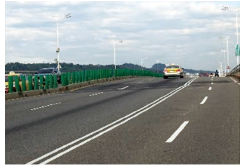
橋面路面不平整現況
