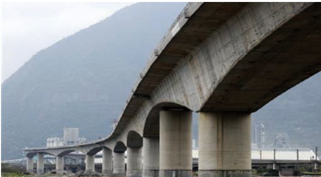
台 9 線蘇花公路南澳和平段工程
