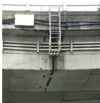
西側鉸接端分離現況
