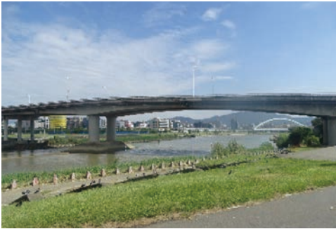
民權大橋中間鉸接端下垂現況
