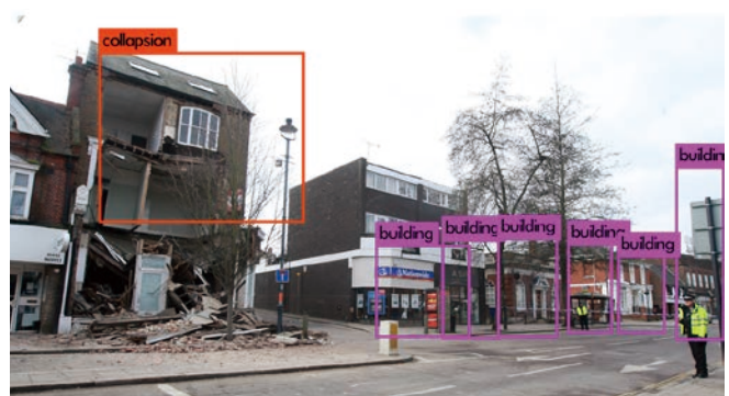
(d) 因災所破壞之房屋
