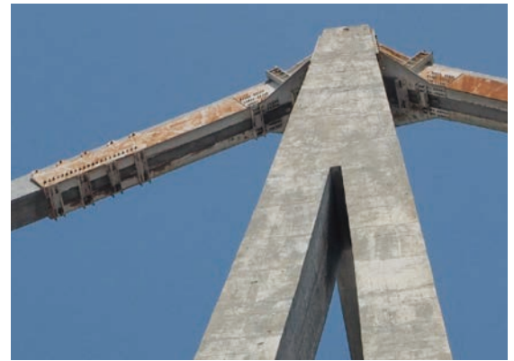
圖 13 莫蘭迪橋 P10 橋塔單元塔頂鞍座加固補強 [10]
