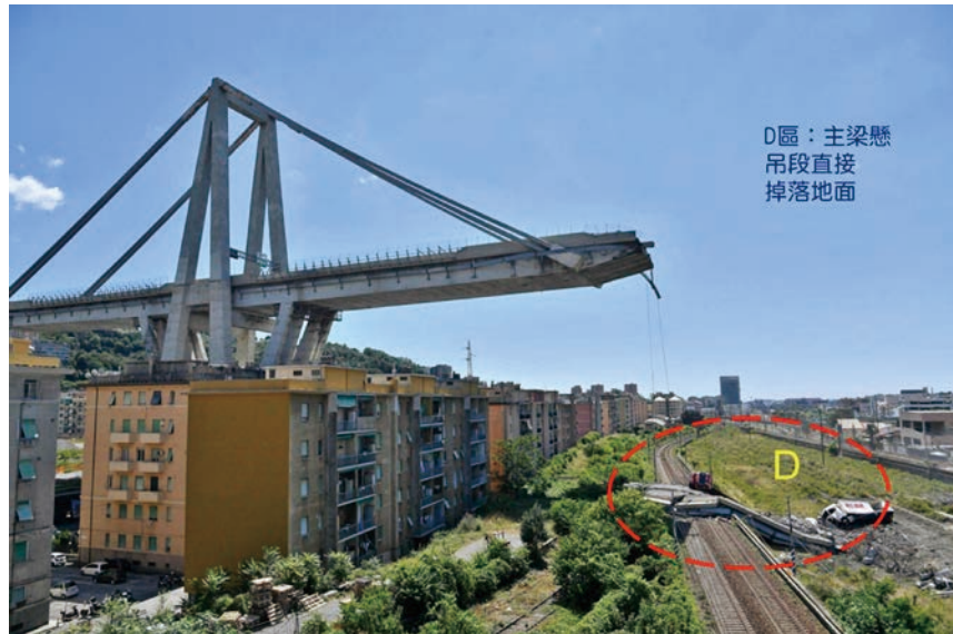
圖 18 橋梁倒塌 D 區照片 [16]
