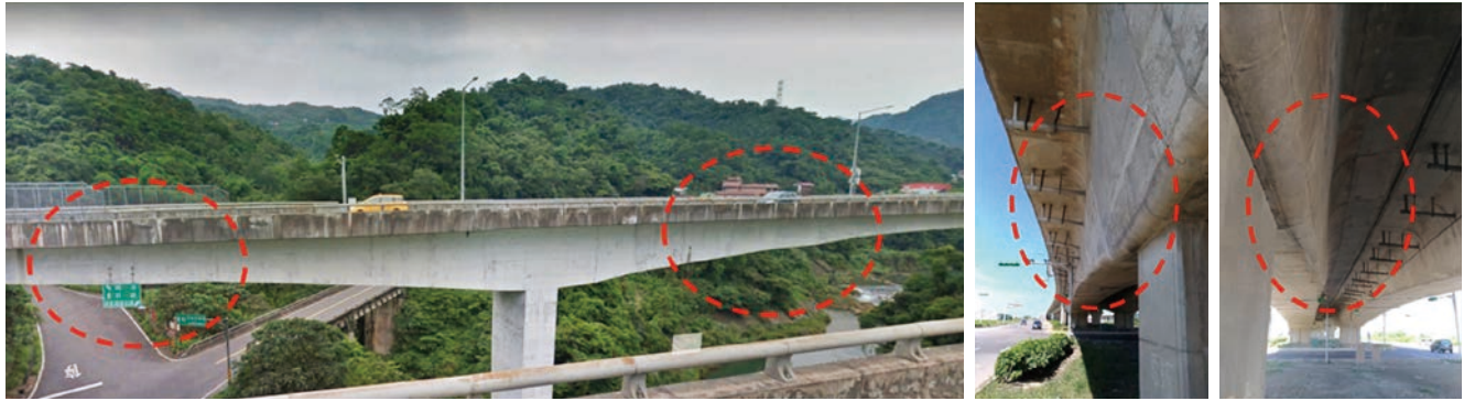
節塊施工線形控制不佳
