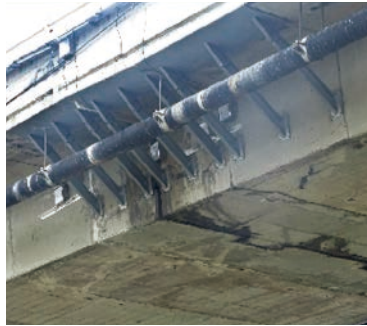
中間鉸接端分離與補強現況
