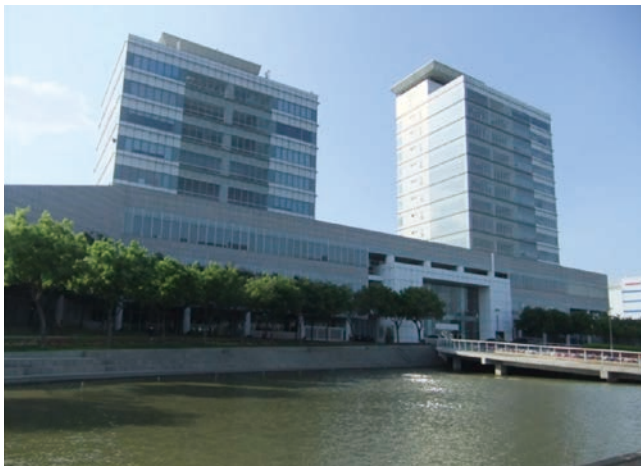
圖 11(a) 中科管理局雙塔建物
