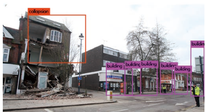
(d) 因災所破壞之房屋
